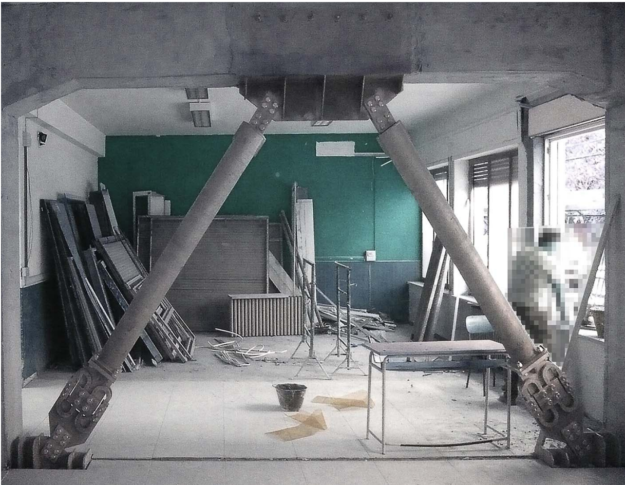
Installazione di controventi dissipativi
