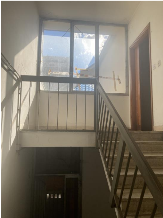
Foto 17_ App. piano primo –vano scale
