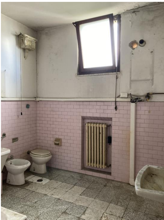
Foto 19_ App. piano primo –bagno
