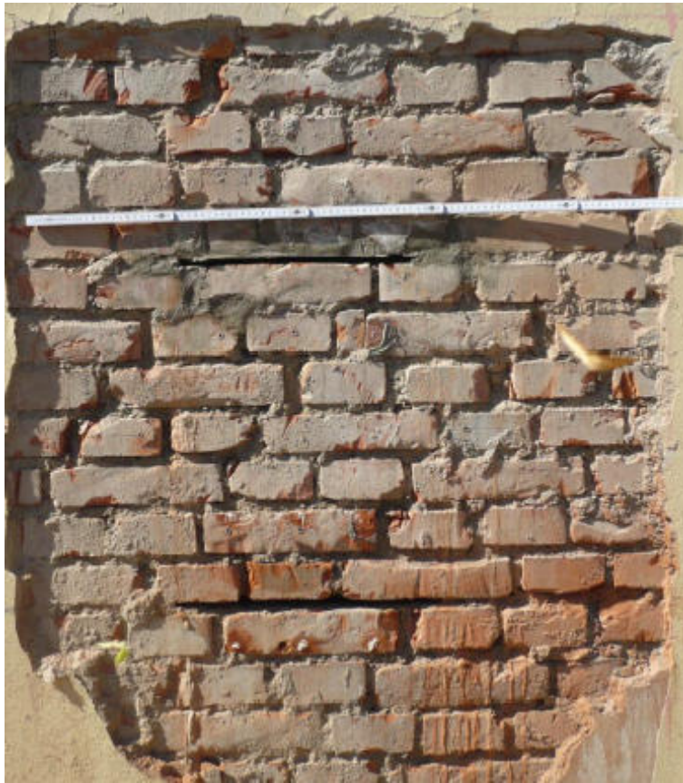
Figura 16 - Saggio F, muratura perimetrale
