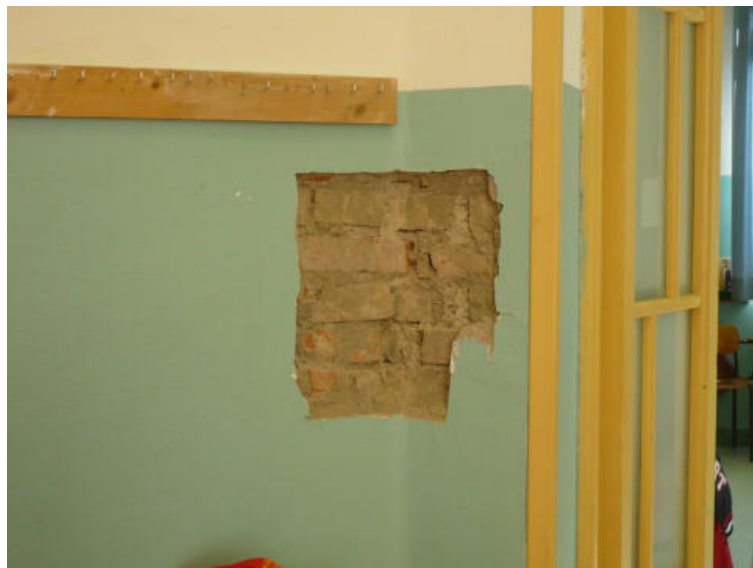
Figura 17 - Saggio L, dettaglio muratura pareti ammorsate
