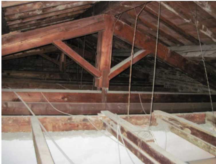
Figura 8 - Vista strutture di copertura
