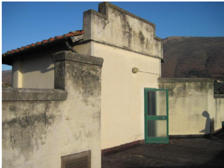
Figura 9 - Parte copertura piana
