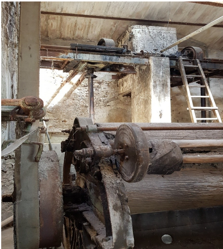
Foto 12 - Interni: locale turbine
