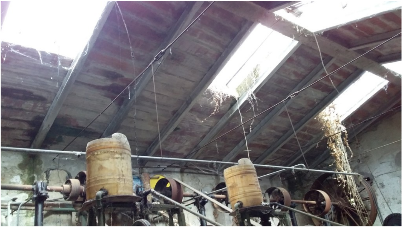
Foto 5 - Copertura locale fole
