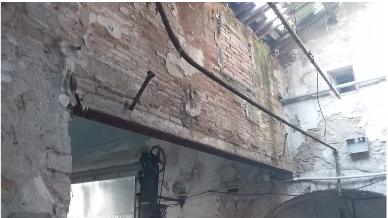
Foto 8 - Profilati doppio "T" zona copertura locale turbine
