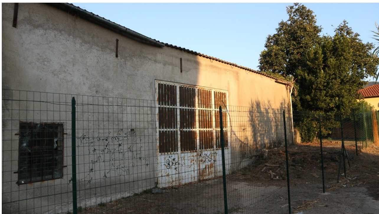
Foto 4 - Facciata anteriore: corpo aggiunto anni '70
