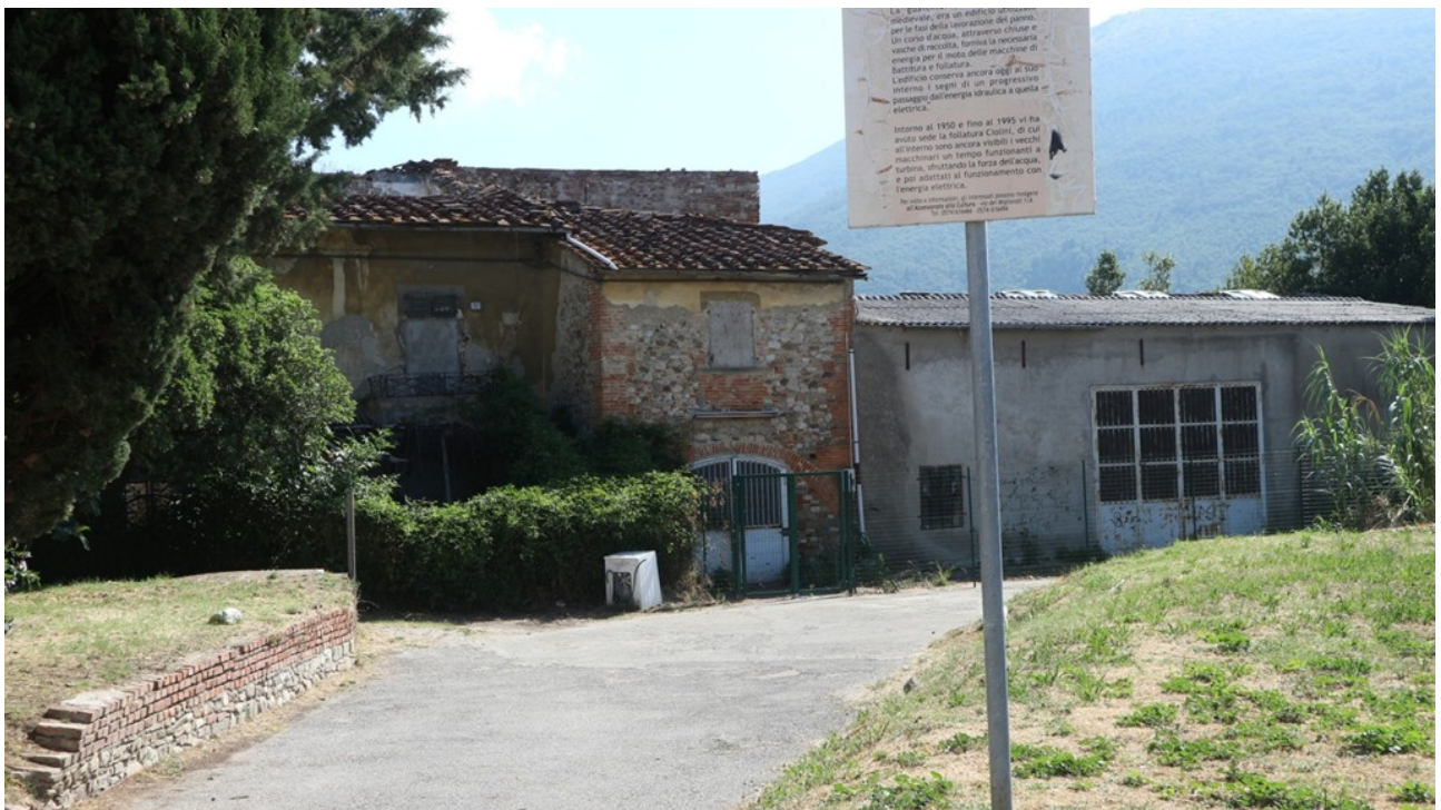
Foto 7 - Facciata anteriore. Ripresa dall'accesso carrabile
