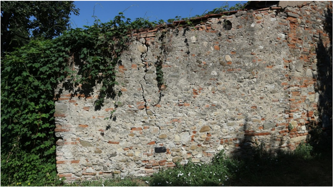
Foto 9 - Lato est prima della ripulitura
