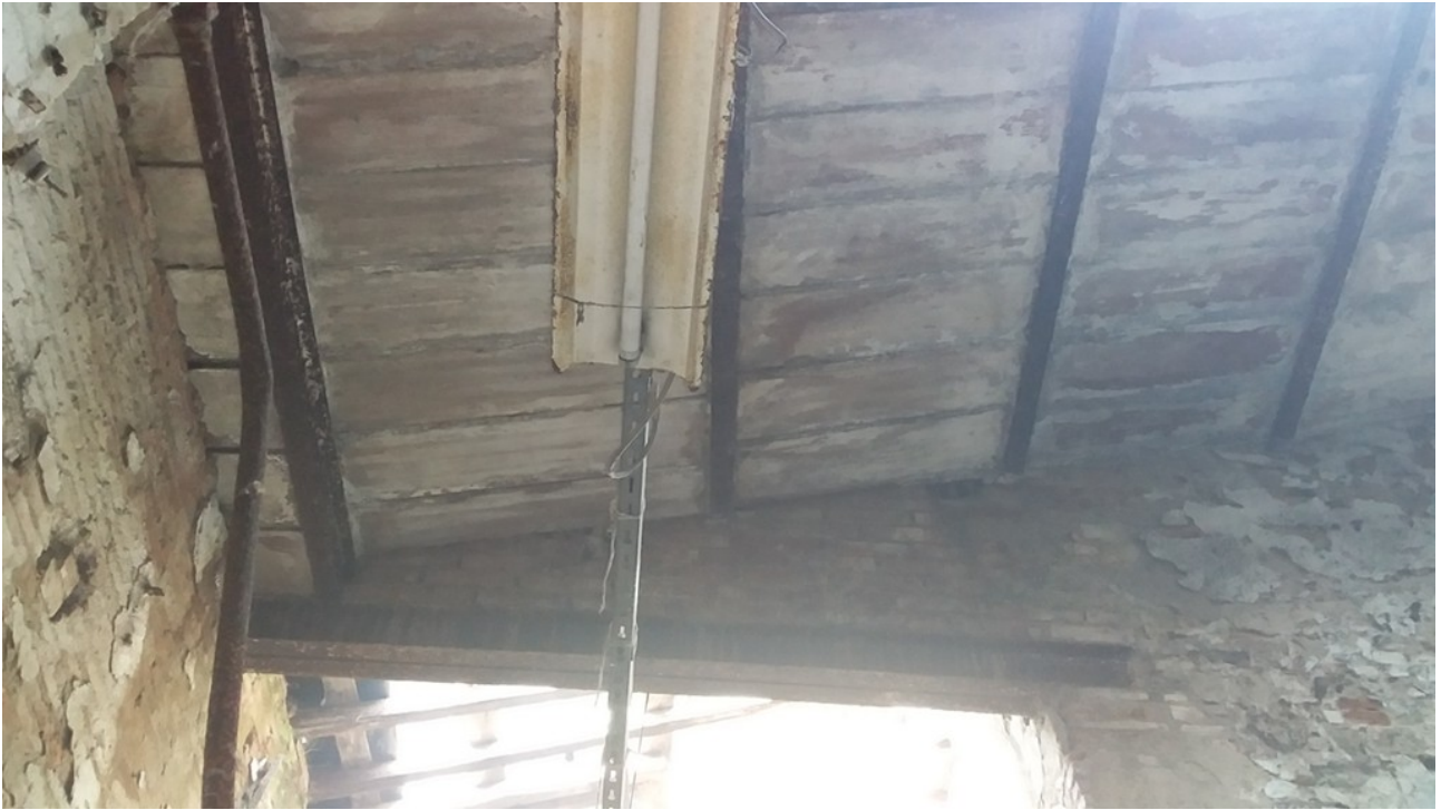
Foto 7 - Profilati doppio "T" zona copertura locale turbine
