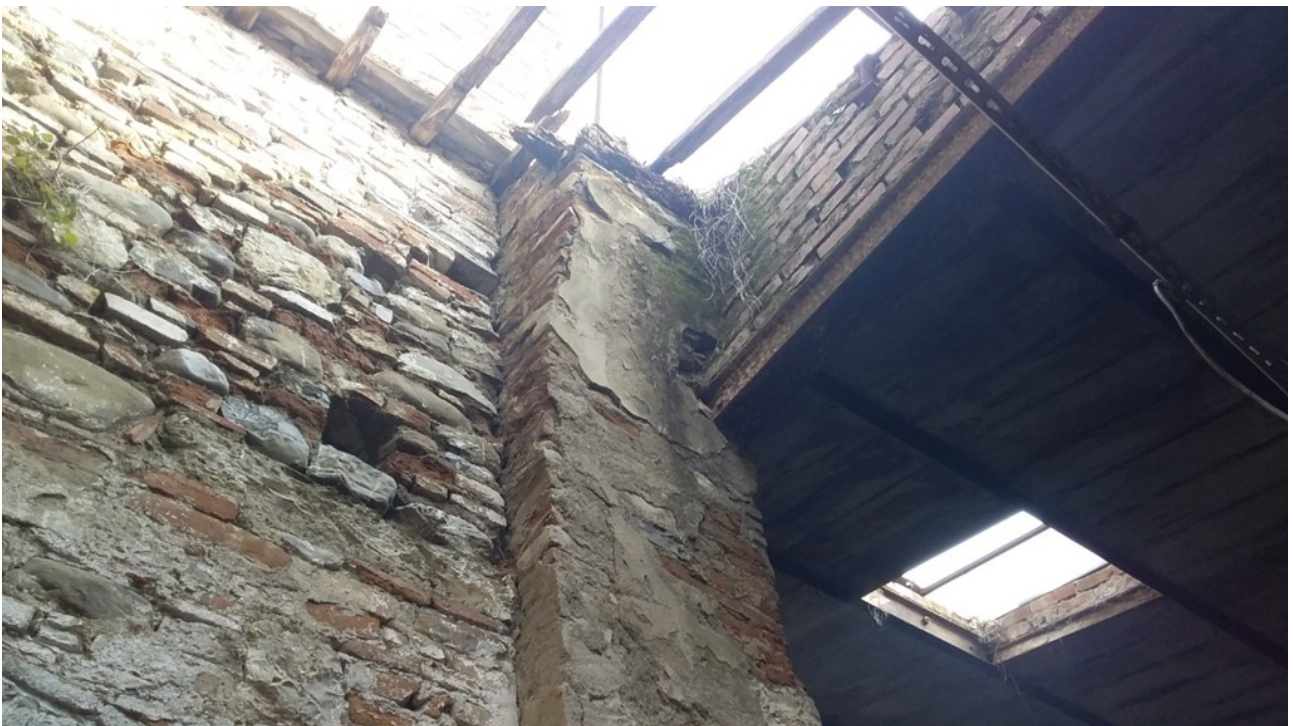
Foto 10 - Profilati doppio "T" zona copertura locale turbine
