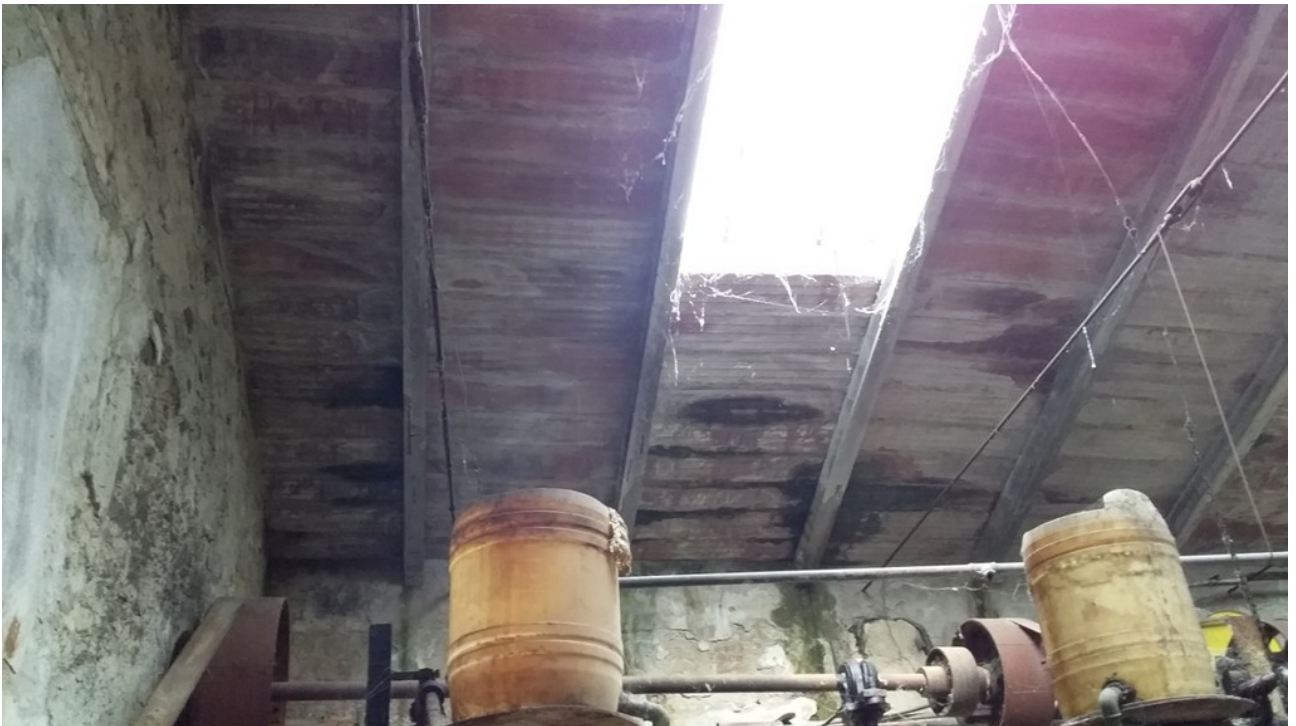
Foto 6 - Copertura locale fole
