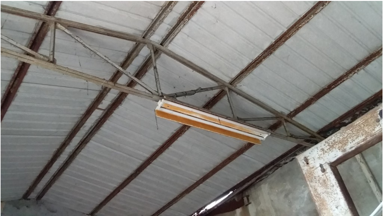
Foto 1- Copertura corpo aggiunto anni '70
