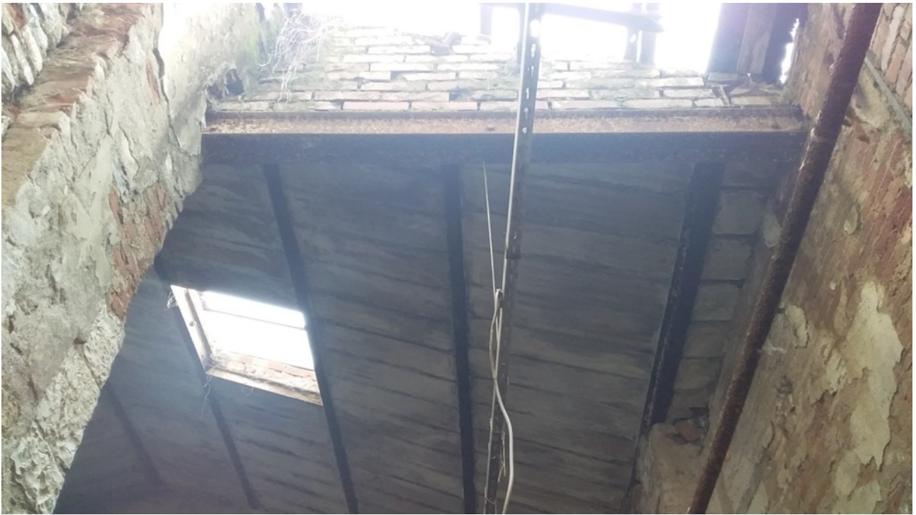
Foto 9 - Profilati doppio "T" zona copertura locale turbine
