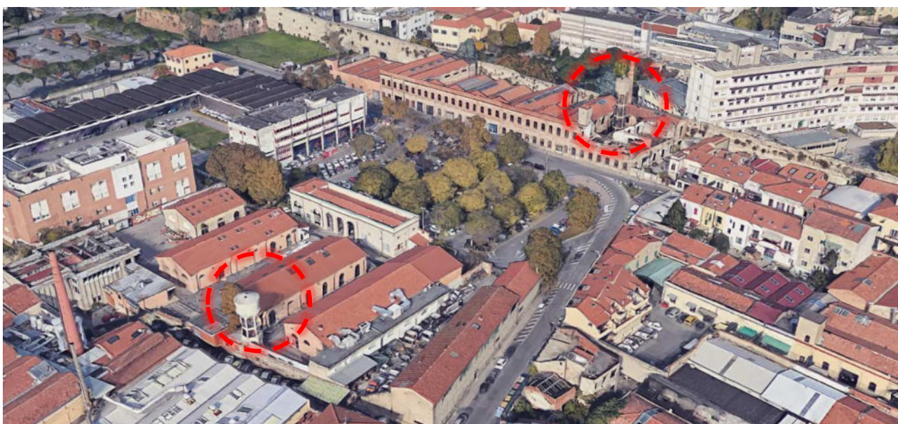
Foto 2 Vista d'insieme dell'area - i due serbatoi
