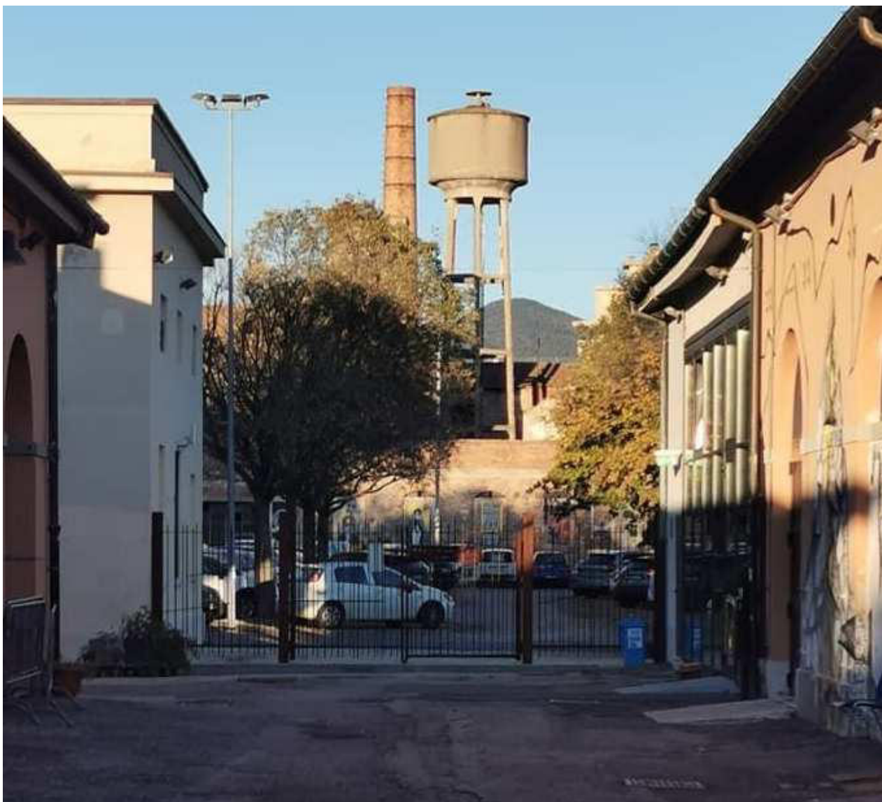
Foto 3: vista dal corridoio centrale della Sala Eventi verso il serbatoio della Ex Fabbrica Lucchesi.
