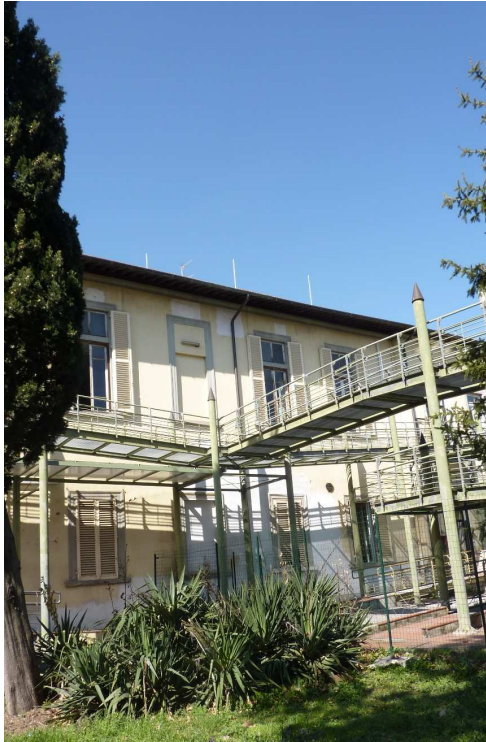
Fig. 3- struttura metallica per esodo barelle della casa di riposo
