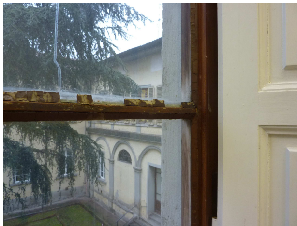
Fig. 2 – particolare infisso piano primo corte interna
