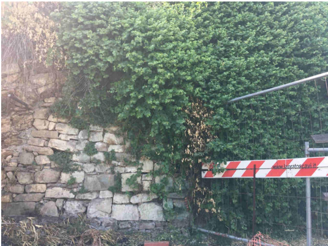
Porzioni di muro a secco
