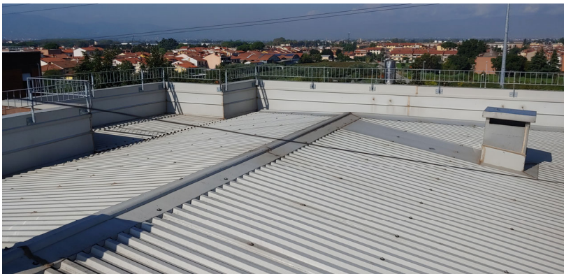
Figura 8. Copertura dei blocchi residenziali
