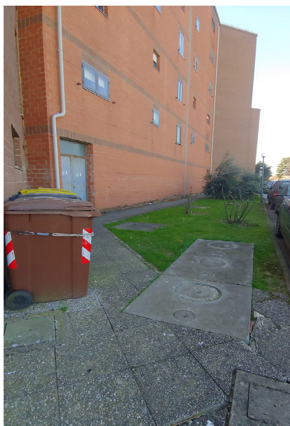
Figura 12. Edificio 1, lato nord
