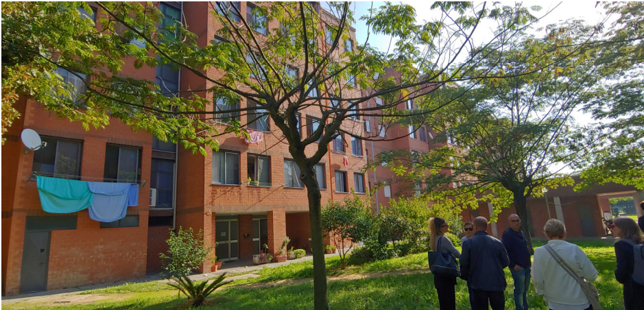
Figura 2. Scoperto centrale del complesso
