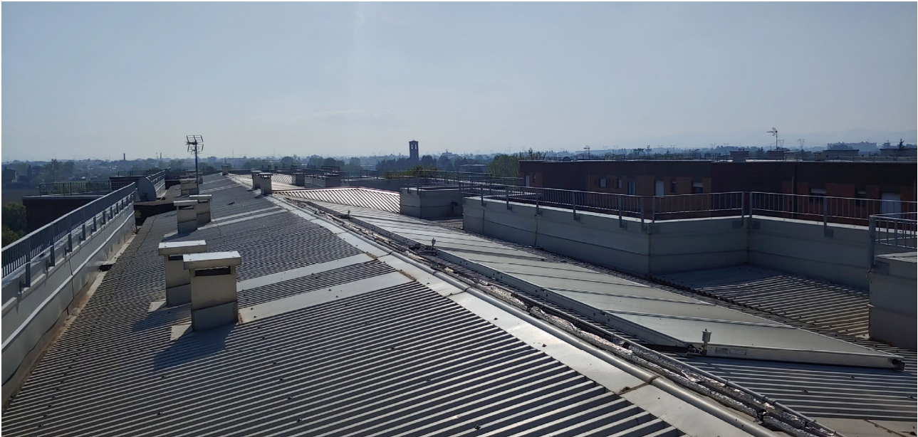
Figura 10. Copertura dei blocchi residenziali
