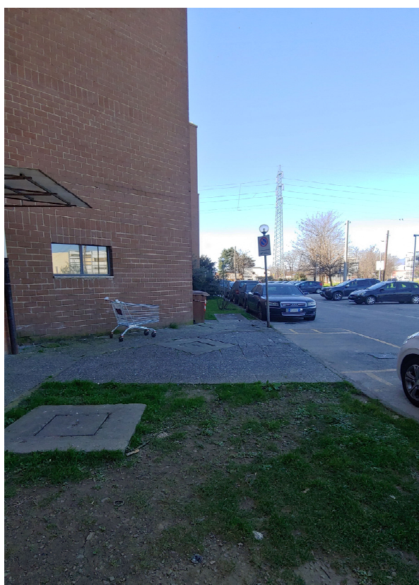
Figura 11. Edificio 1, lato nord
