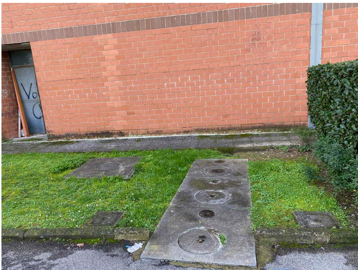
Pavimentazione esterna ed.1 lato nord
