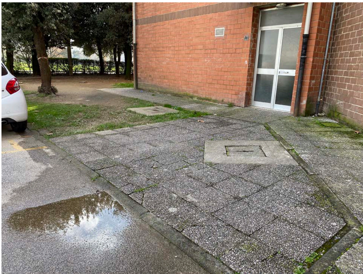
Pavimentazione esterna ed.1 lato nord
