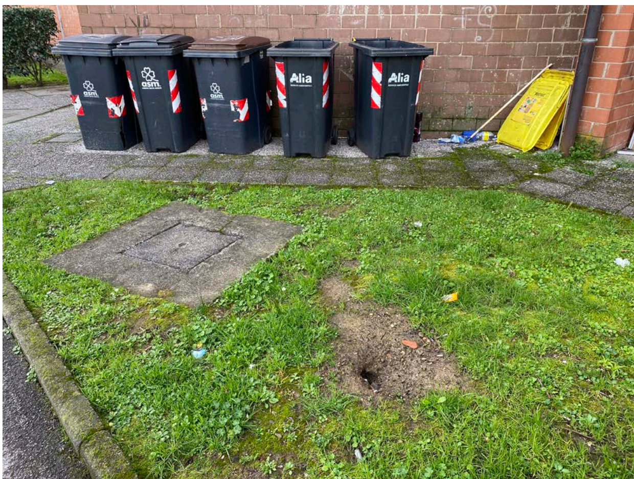
Pavimentazione esterna ed.1 lato nord
