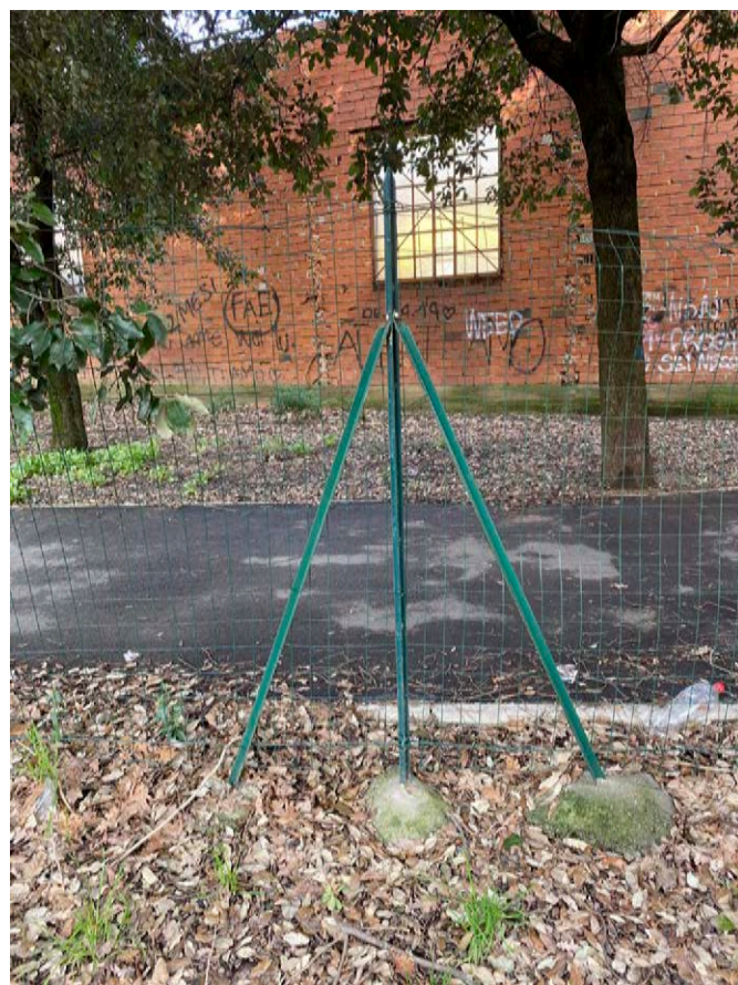
Rete di confine lato ovest
