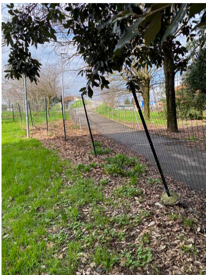
Rete di confine lato ovest
