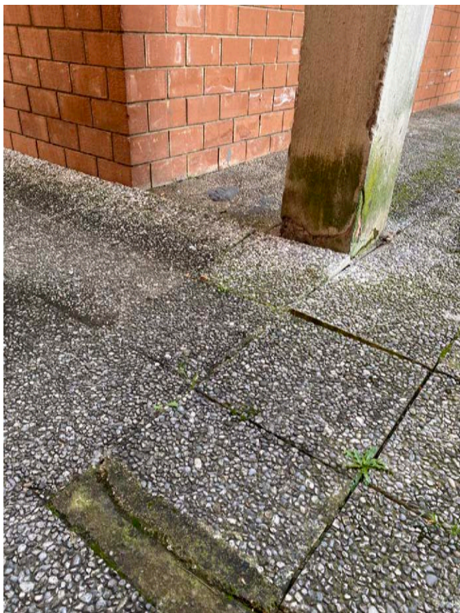
Esterno tra cantina est ed ed.3 lato nord
