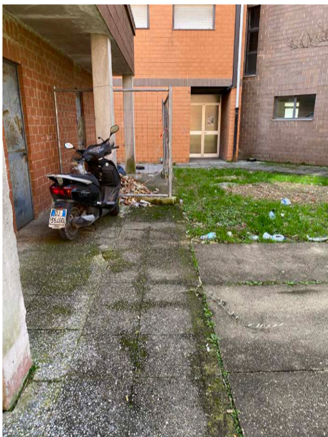
Esterno cantina ovest, lato ovest
