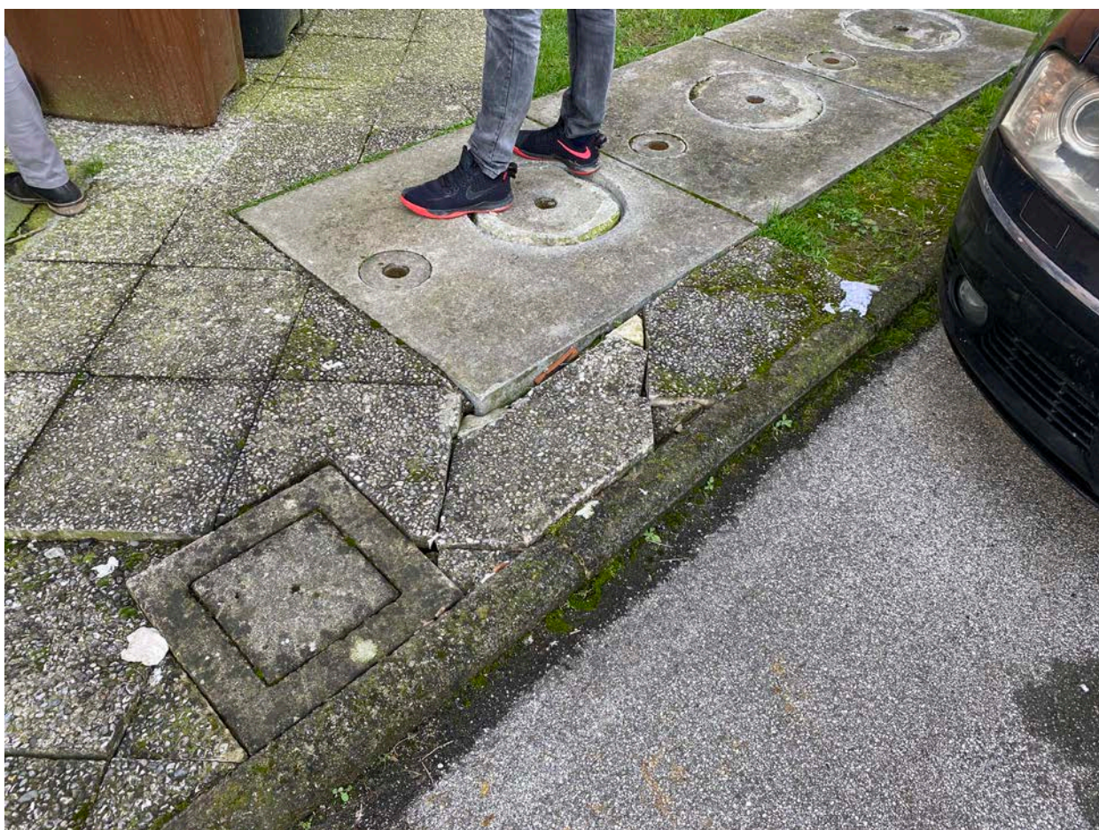
Pavimentazione esterna ed.1 lato nord
