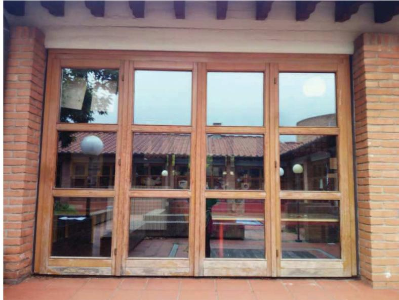
A causa dei disallineamenti delle strutture di sostegno di alcuni infissi per invecchiamento, si sono formati molti spifferi e nel periodo invernale causano l'abbassamento delle temperature nei locali riscaldati.
