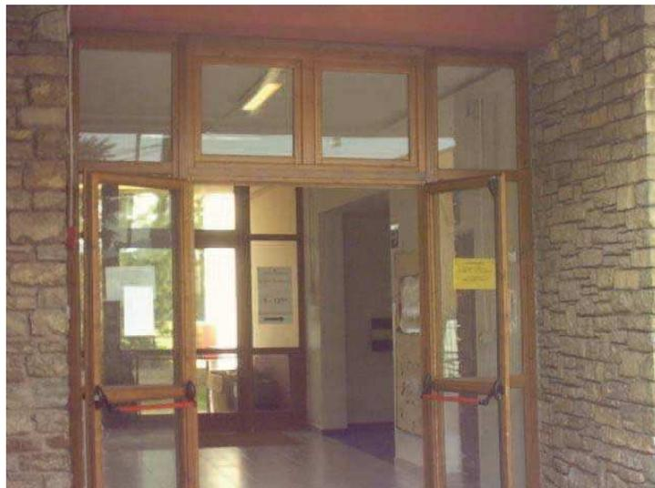
Ogni aula è dotata di uscita di emergenza verso l'esterno e scalini in muratura per arrivare al livello del suolo; gli infissi sono sempre in legno, vetro semplice e dotati di maniglione antipanico.
