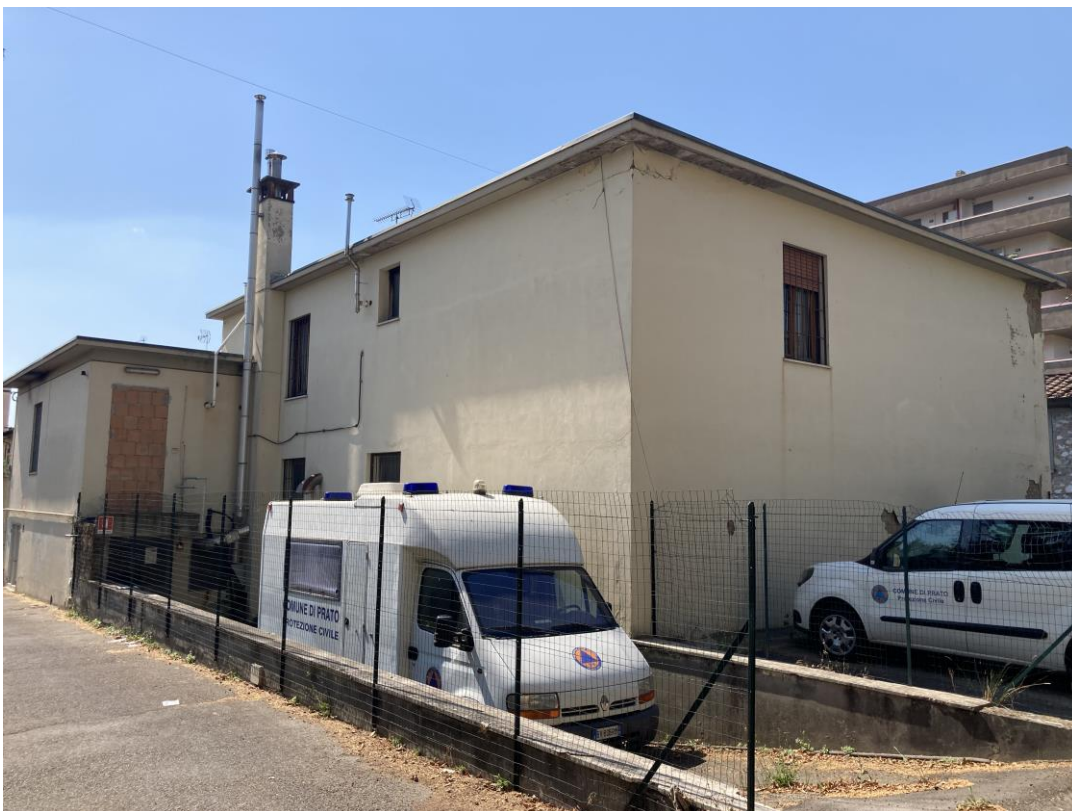
Foto 4_ Prospetti su corte interna
