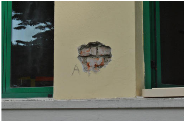
Figura 14 - Saggio A muratura tra le finestre piano terra prospetto verso via Badiani
