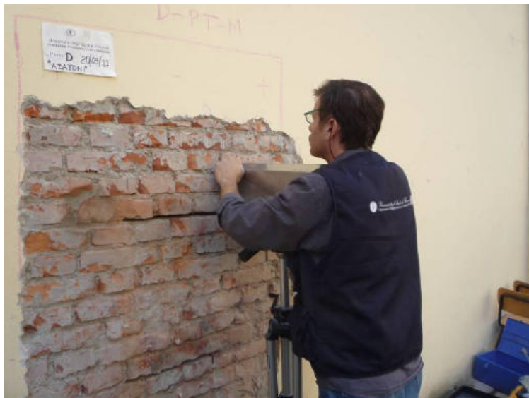
Figura 15 - Saggio D, muratura perimetrale oggetto di prove con martinetto piatto
