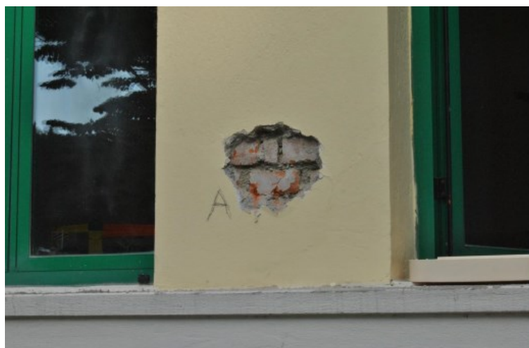
Figura 3 - Saggio A muratura tra le finestre piano terra prospetto verso via Badiani
