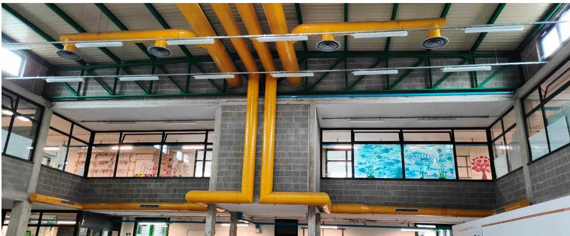
Figura 4 - Copertura del locale mensa all'intradosso
