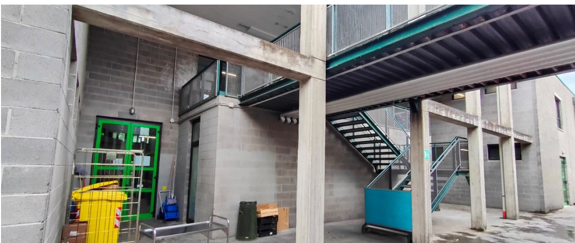
Figura 14 - Accesso da Via Toscanini
