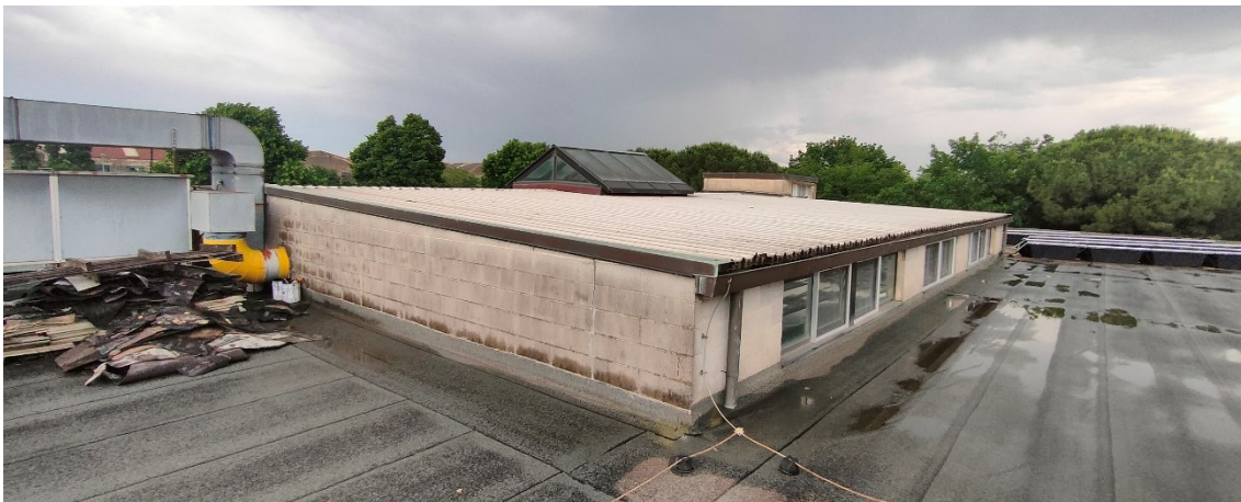
Figura 16 - Copertura del locale mensa oggetto d'intervento
