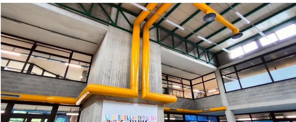
Figura 5 - Copertura del locale mensa all'intradosso
