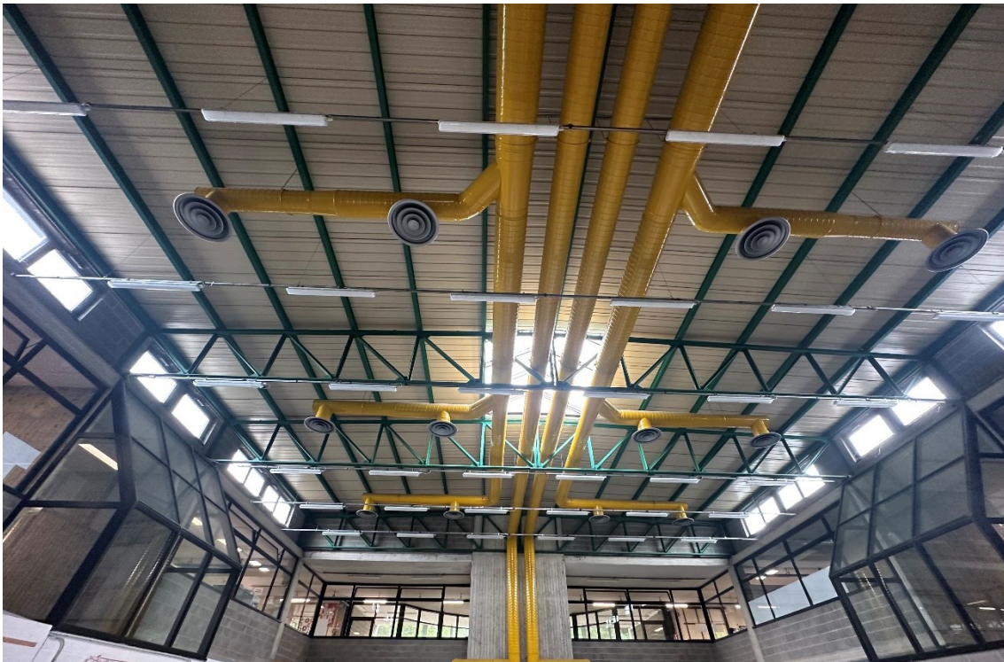
Vista della copertura rialzata del locale mensa dal basso
