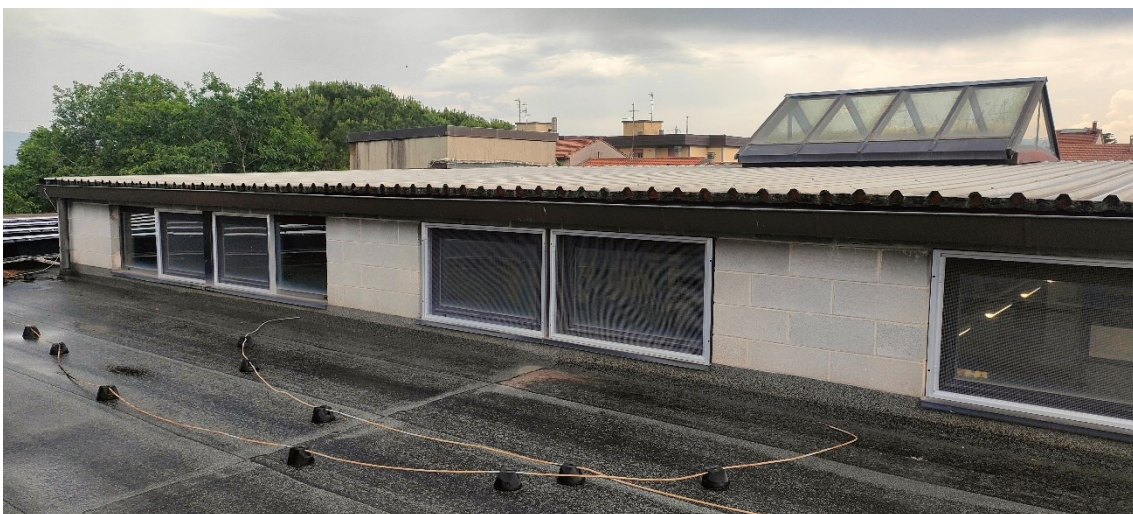
Vista della copertura rialzata dall'alto
