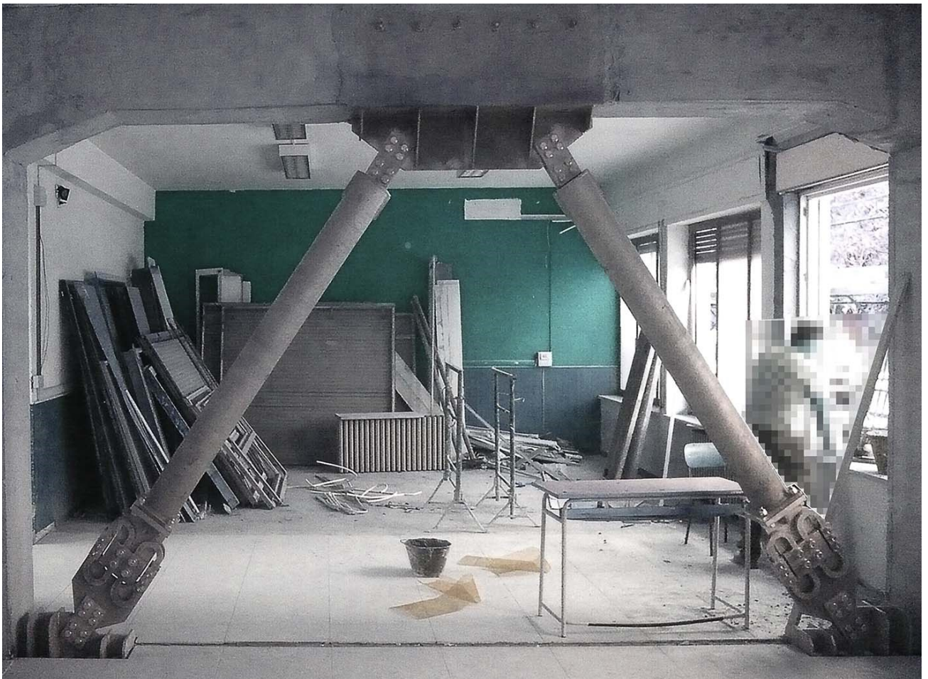
Installazione di controventi dissipativi
