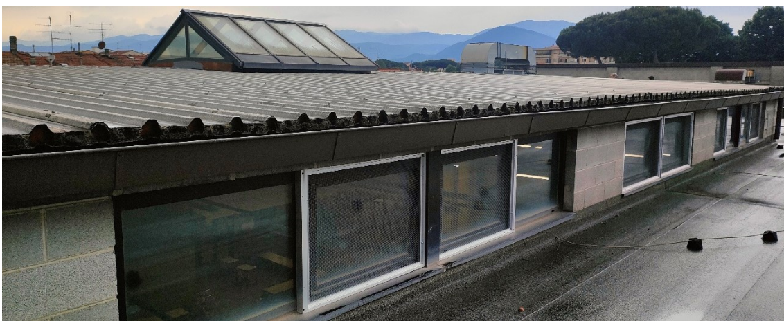
Figura 17 - Copertura del locale mensa oggetto d'intervento
