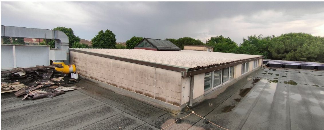
Figura 16 - Copertura del locale mensa oggetto d'intervento
