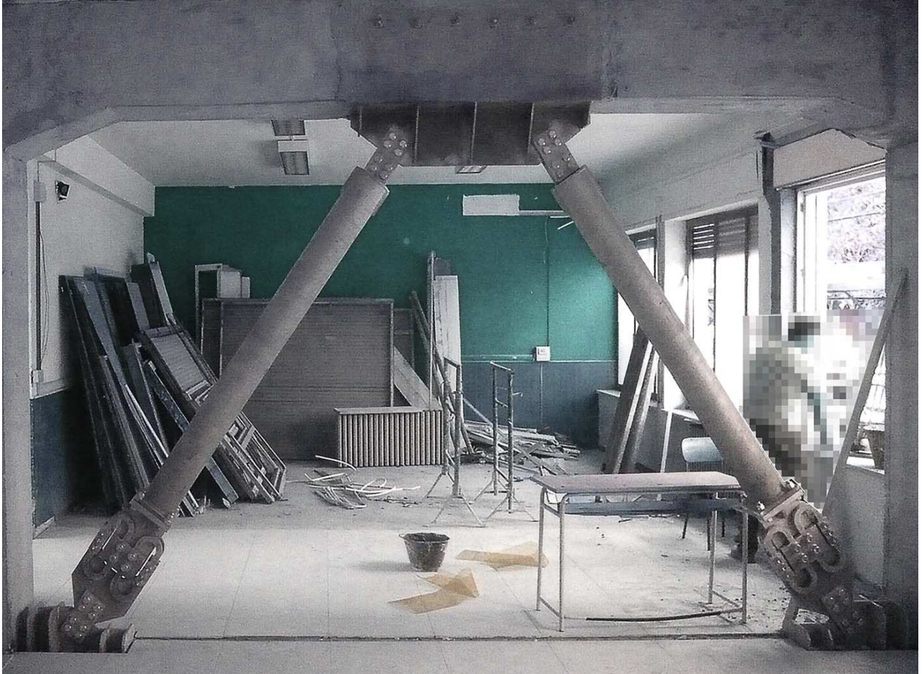
Installazione di controventi dissipativi
