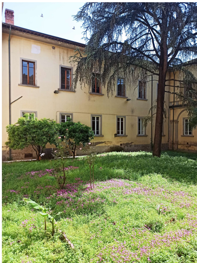
Foto n. 9 e n. 10 – Prospetti cortile interno
