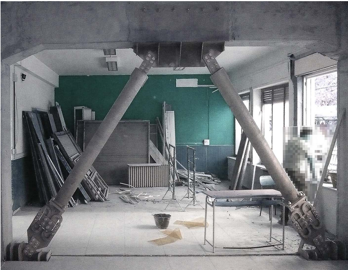
Installazione di controventi dissipativi
