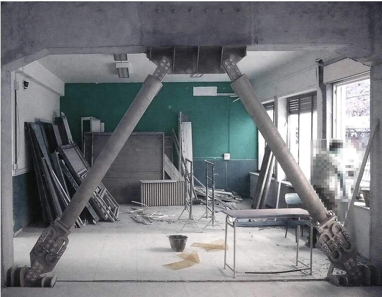
Installazione di controventi dissipativi
