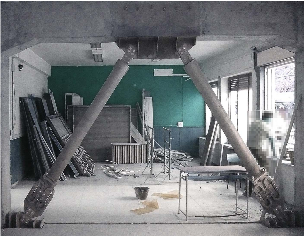
Installazione di controventi dissipativi
