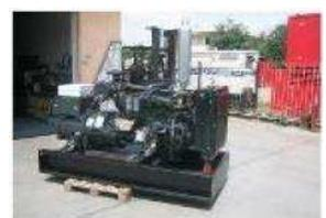
energia elettrica, anche a gruppi elettrogeni che sono messi in funzione in caso di interruzione della fornitura di rete. Il passaggio dall'alimentazione di rete a quella di uno o di un altro gruppo elettrogeno è attuata mediante appositi sezionatori.
