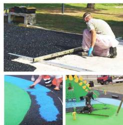
1) PAVIMENTAZIONE ANTITRAUMA stratigrafia con nuova pavimentazione antitrauma in gomma colata
