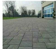
1) PAVIMENTAZIONE DRENANTE stratigrafia con nuova pavimentazione in autobloccanti in cls tipo Paver modello Varsavia
