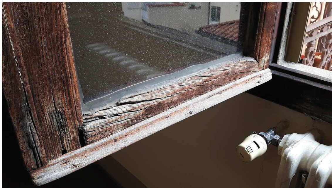
infisso P2.15 - stato attuale – battuta inferiore
