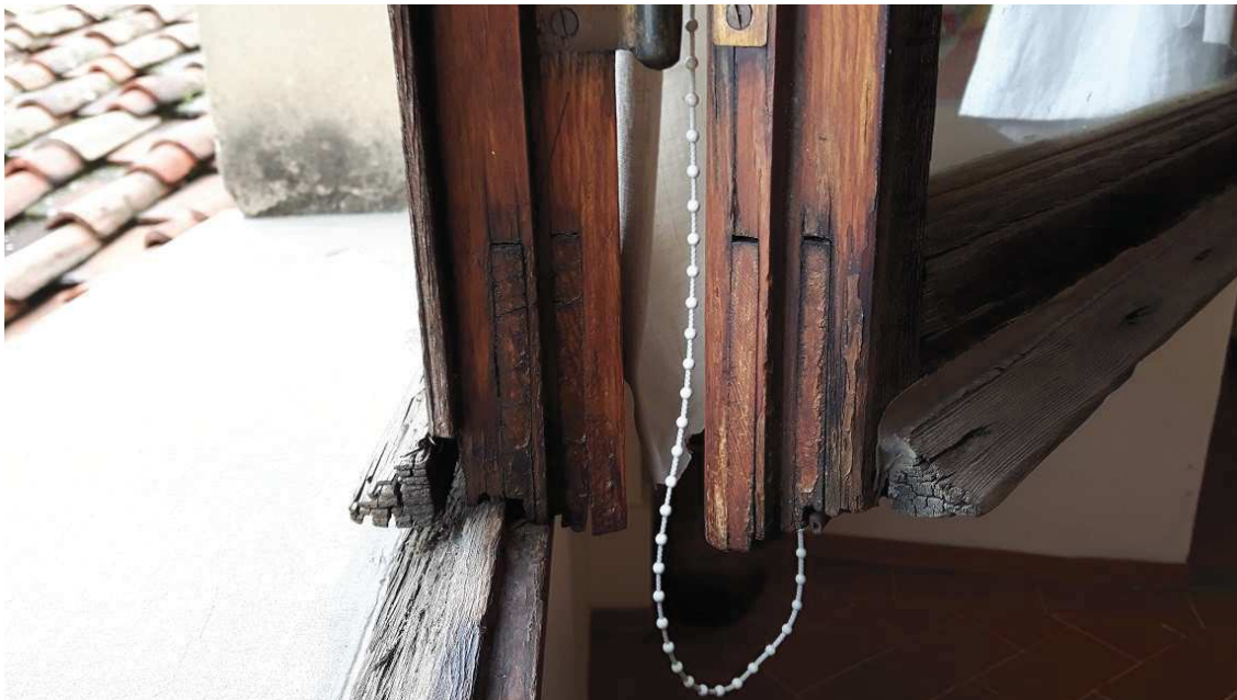
infisso P3.01 - stato attuale – nodo intermedio inferiore
