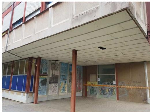
*Ante-operam*, il tamponamento è costituito da pannelli prefabbricati in cemento armato, dello spessore (maggiore sulle nervature) di 10-15 cm, con graniglia di finitura e nervature irrigidenti esterne.
