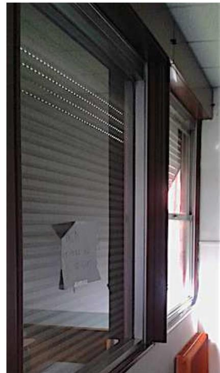
Probabilmente, all'inizio erano interamente in ferro, e successivamente saranno stati sostituiti con dei profili in alluminio inseriti nei controtelai originali, per evitare di dover ricostruire gli ancoraggi nel vuoto strutturale dei pannelli.
