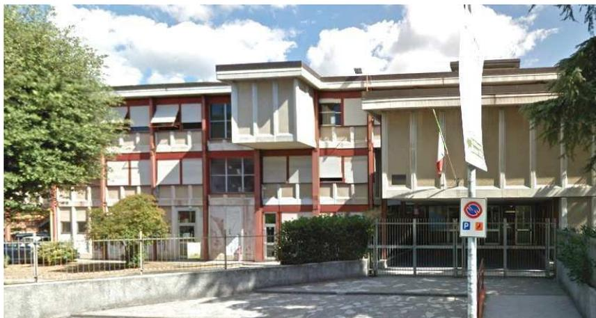
L'edificio è stato costruito nel 1974 con tecniche di fabbricazione per i tamponamenti e strutture portanti in acciaio profilato, ed è caratterizzato da un'alta incidenza delle parti vetrate sulla superficie dei prospetti.
