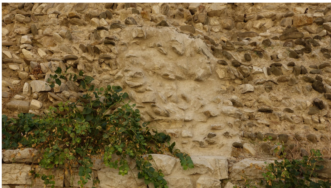
PARTICOLARE DELLA PROVA DI FINITURA A PROTEZIONE DELLA CORTINA MURARIA
