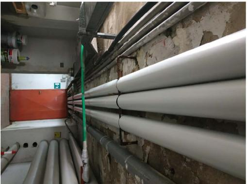
Tubazione idrica stoffata su solai ammalorati
