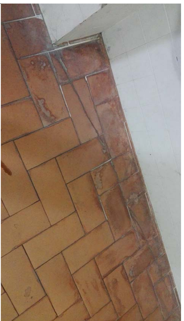
Foto pavimentazione piano vasca in cotto
