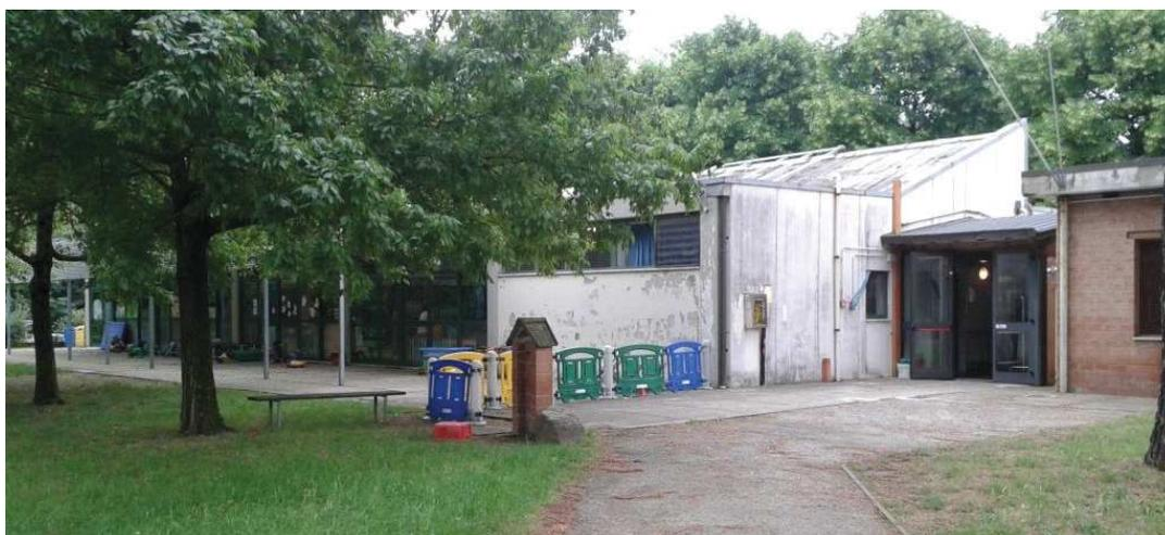
La parte di edificio che ospita la scuola materna presenta invece una struttura in cemento armato, con tamponamenti in mattoni semipieni faccia-vista. La copertura a padiglione è in cemento armato, il cui estradosso è protetto da pannelli in lamiera grecata.
