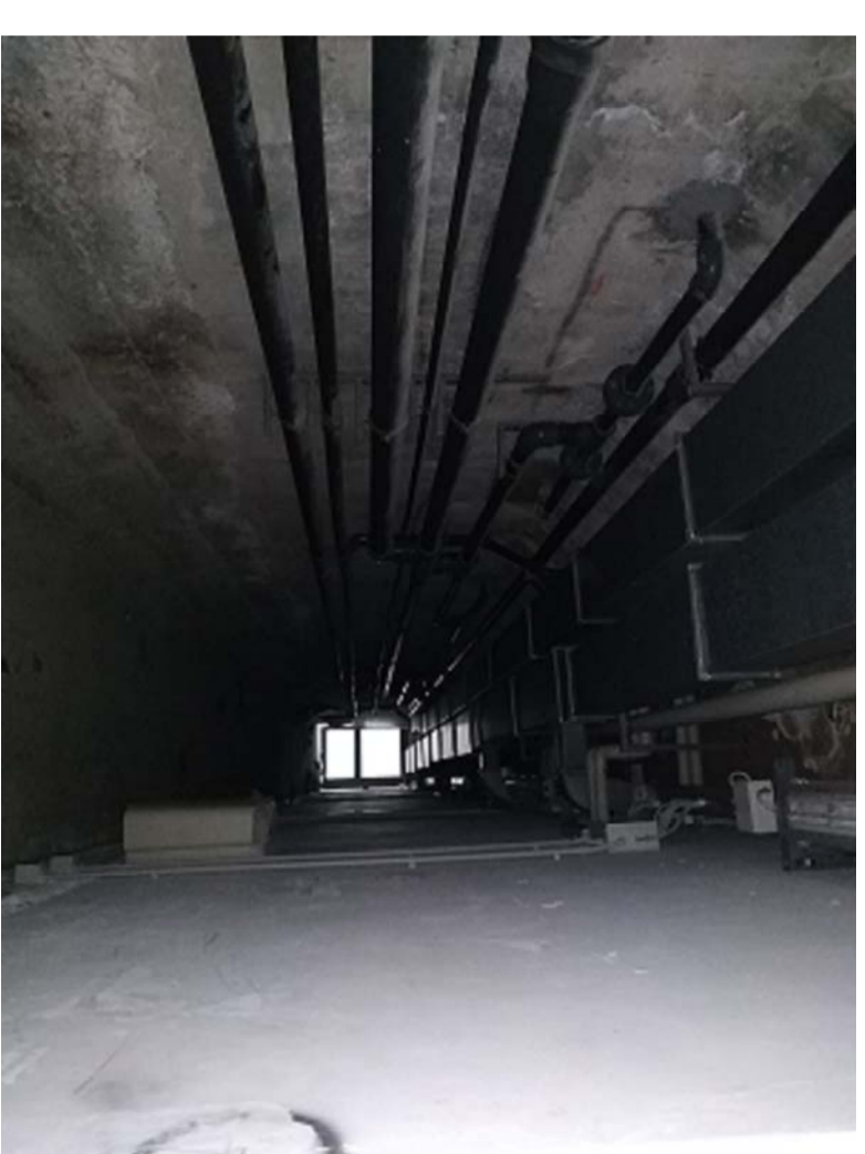
Foto corridoio uscita di emergenza
