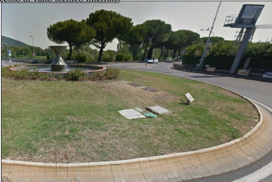
Accesso al vano tecnico interrato
