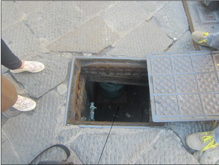
Accesso al vano tecnico interrato
