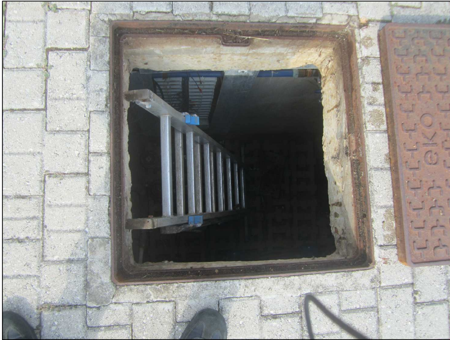
Accesso al vano tecnico interrato
