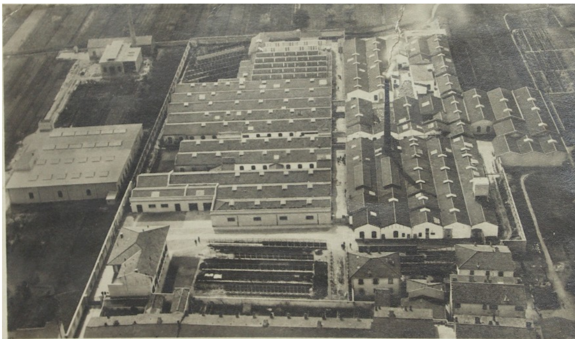
Foto aerea dello stabilimento – Anni Trenta del Novecento (cartolina postale)
