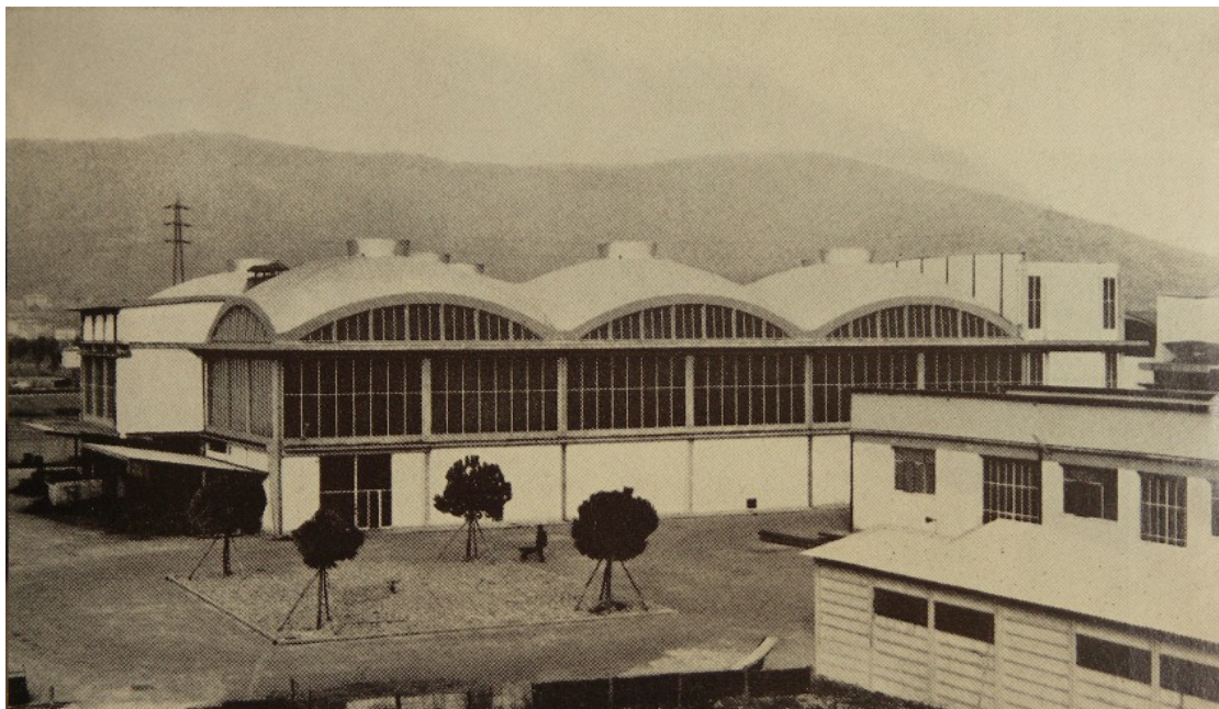
Veduta esterna della fonderia dopo la sua realizzazione (“Il Laterizio” Bollettino tecnico Erredibi, n° 130, anno 22, ottobre 1971, pp. 890-891)
