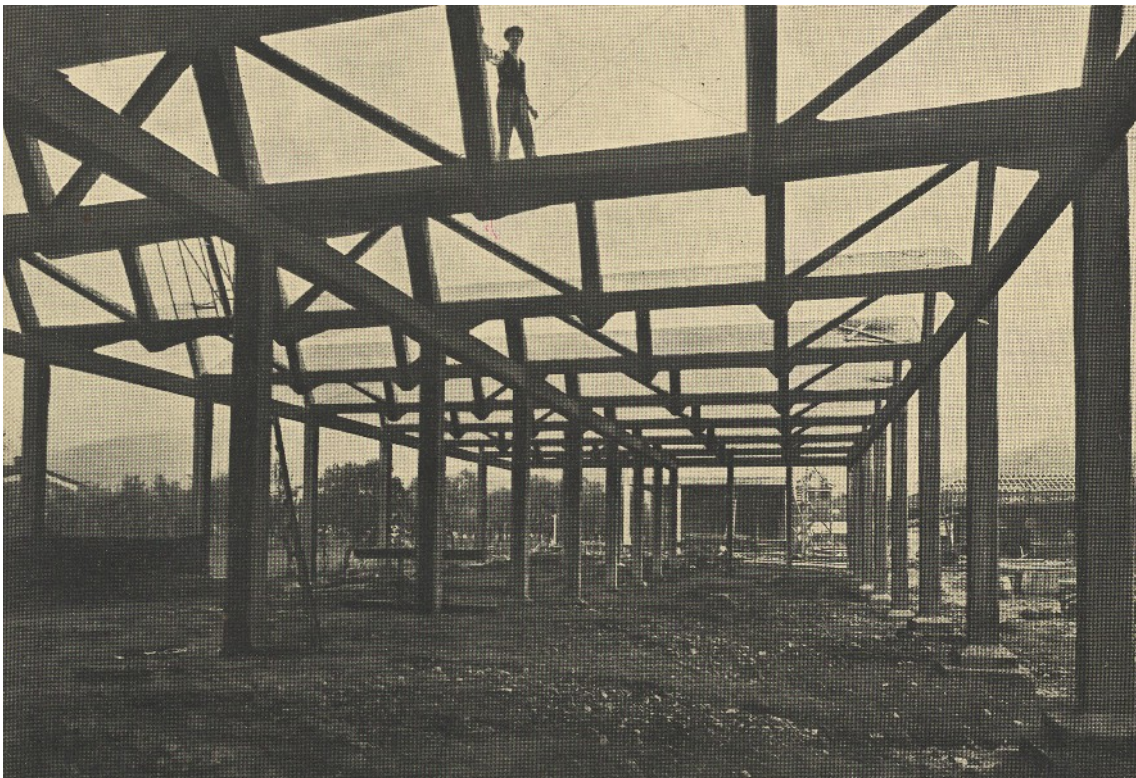
Cantiere per la costruzione dei capannoni a shed – 1928 (Album dei lavori realizzati dalla Nervi & Nebbiosi)
