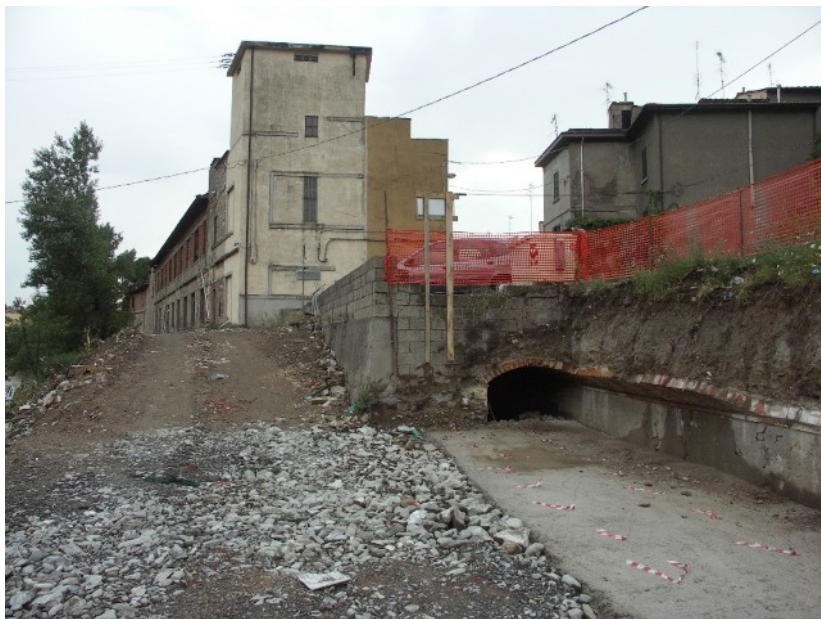
Gora sotterranea venuta alla luce durante i lavori di allargamento della S.R. 325
