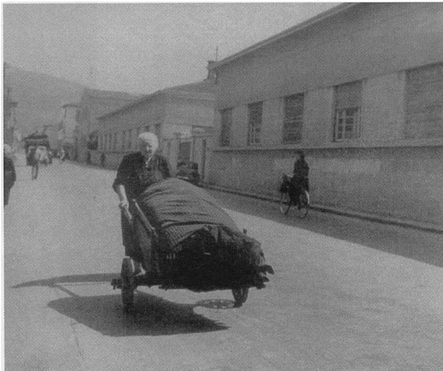
Esterno della fabbrica Mazzini su via Bologna – anni Cinquanta – (AFT – fondo Bencini)
