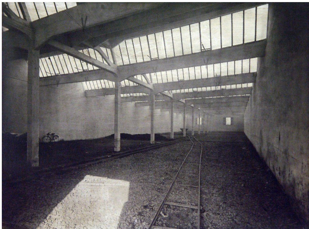
Interno di uno dei capannoni appena realizzato
