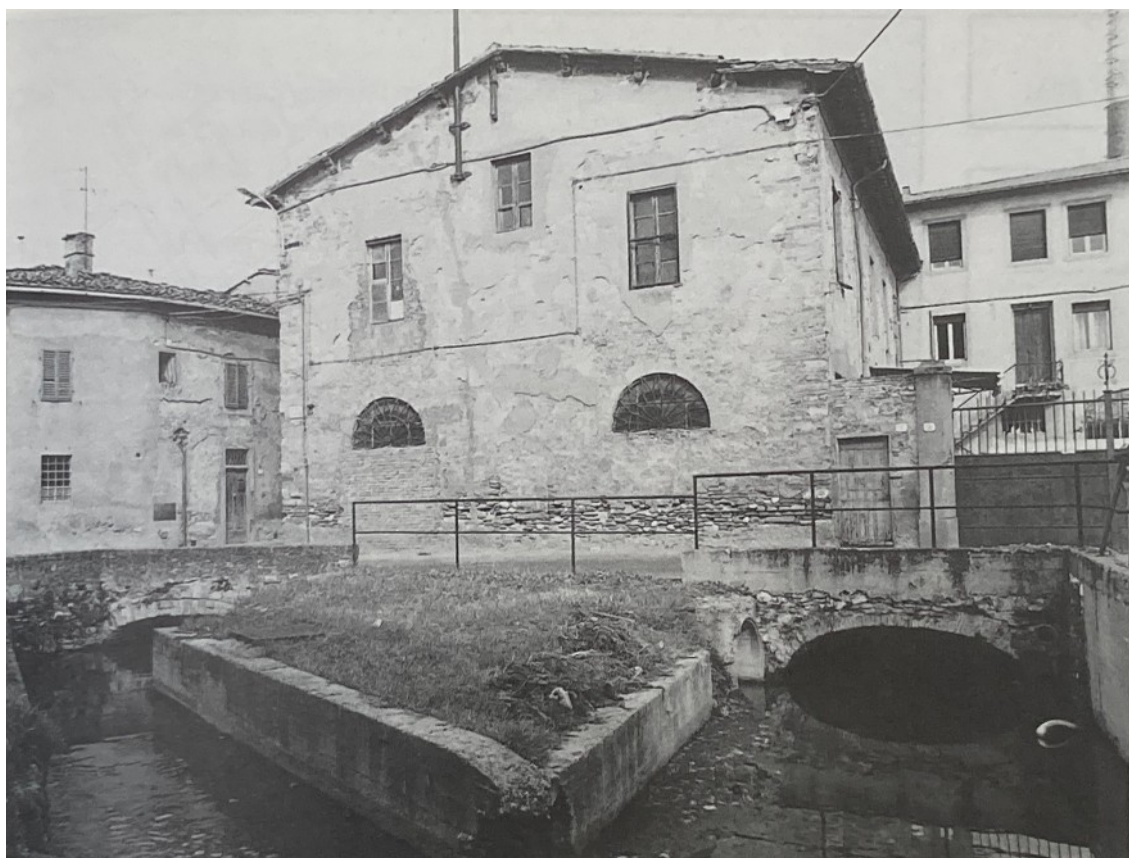
L'edificio del mulino, con le due gore ancora scoperte – 1983 ( G. Guarducci, R. Melani, Gore e mulini della piana pratese. Territorio e architettura, Prato 1993, ed Pentalinea, p.67)
