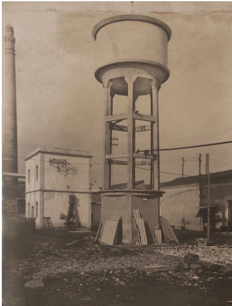
Deposito aereo in cemento armato appena realizzato
