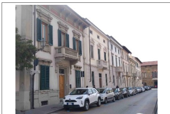
Edifici su via Dante
