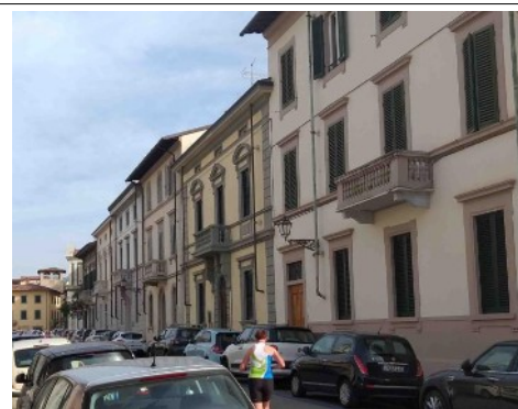
Edifici su via Dante
