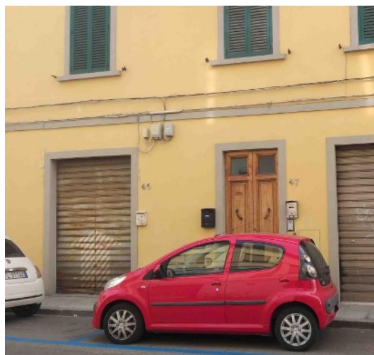
Edificio su via Frascati
