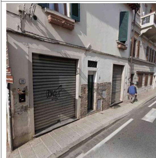
Edificio su via Frascati
