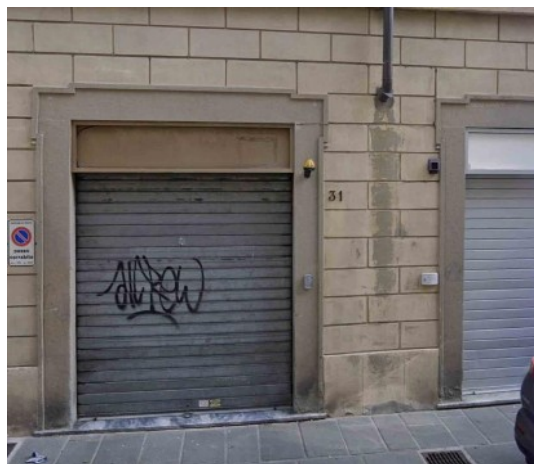
Edificio su via Tinaia
