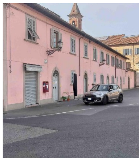
Palazzo del Conservatorio di San Niccolò
