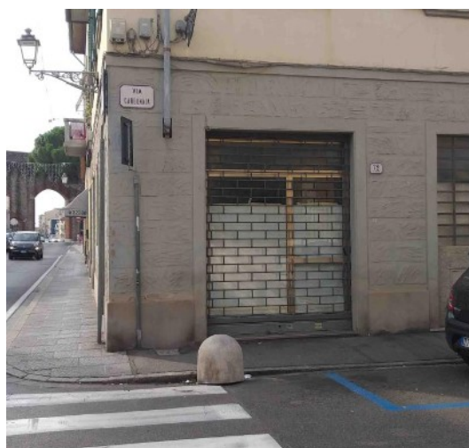
Edificio su via Carbonaia
