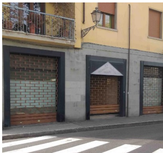
Edificio su via Carbonaia
