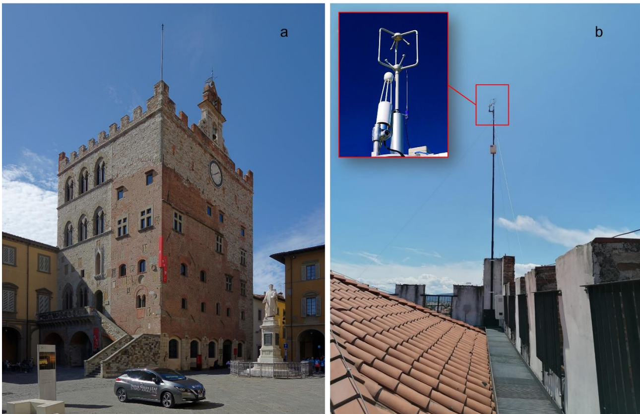
Figura 1. Installazione della stazione Eddy Covariance su Palazzo Pretorio (a) nel centro della città di Prato. A destra (b) dettaglio della strumentazione utilizzata comprensiva di analizzatore di gas ad infrarosso e anemometro triassiale.
