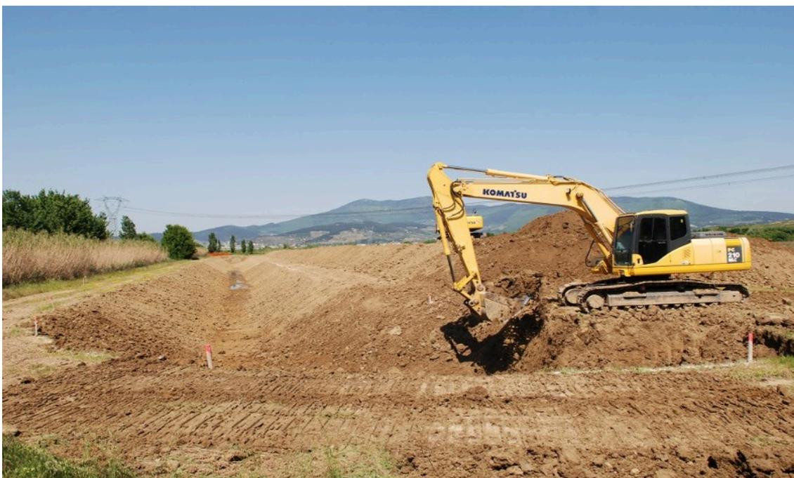
**Figura 12** - Il nuovo tratto del canale Garille all'interno dell'Oasi WWF Stagni di Focognano. Il canale, precedentemente caratterizzato da fondo e pareti verticali in cemento (si veda la Fig. 2 a pag. 16 della I Parte dello Studio), è stato completamente rinaturalizzato nel 2011 (Progetto: WWF – Comune di Campi Bisenzio – Consorzio di Bonifica) per evitare ogni possibilità di caduta e morte delle specie durante il passaggio da una sponda all'altra.
