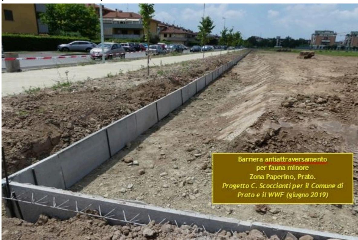
**Figura 11** - Ultime fasi di costruzione di una barriera antiattraversamento per la tutela della fauna
