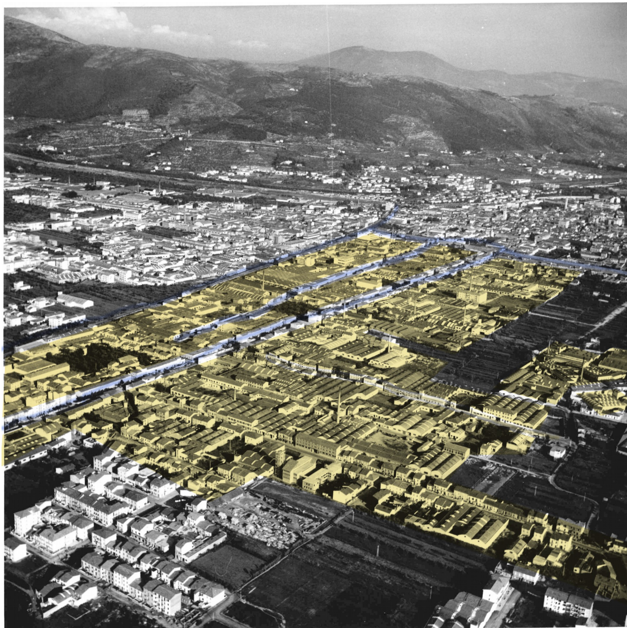
fig. 6 - Ripresa aerea del 1963 con evidenziati gli insediamenti produttivi che si attestano sulla via Pistoiese e la via Filzi (archivio Ranfagni).
