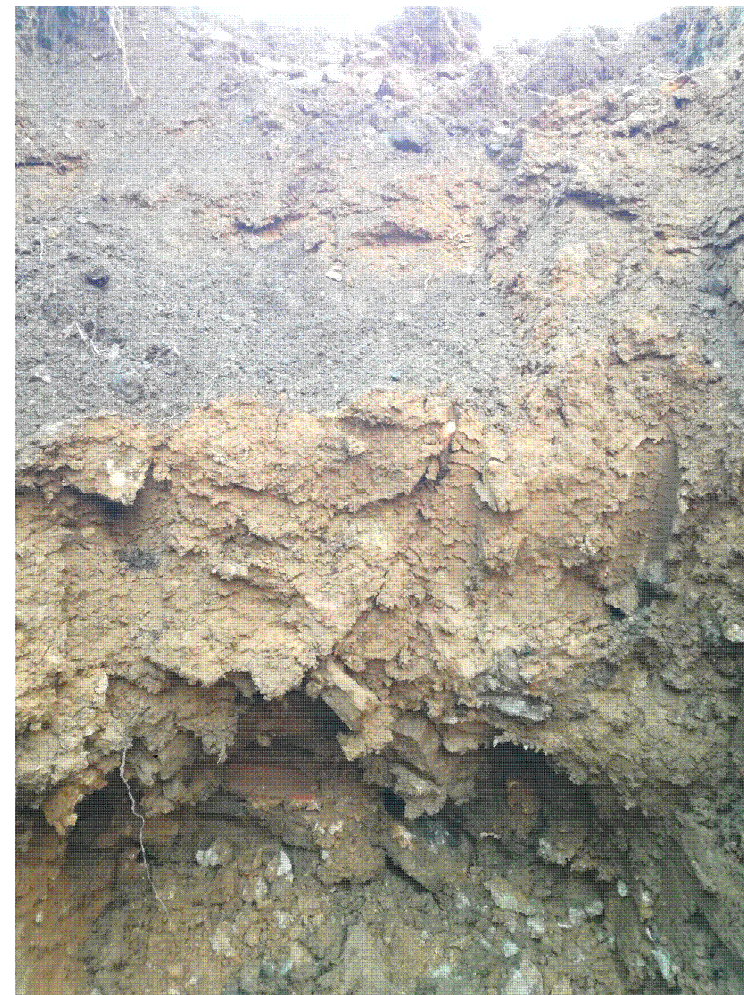
foto del terreno da 0,0 m a 1,2 m p.c.
