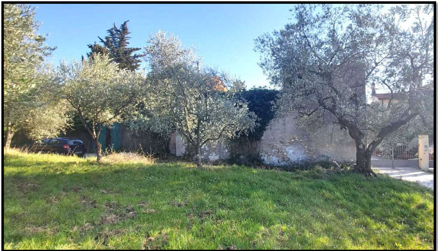
Foto n.2 – Prospetto Nord, lato strada Via di Cerreto e Solano.
