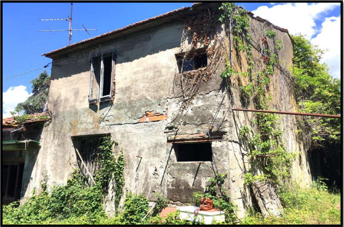
Foto n.3 – Prospetto Sud-Est; porzione edificio adibita ad abitazione.
