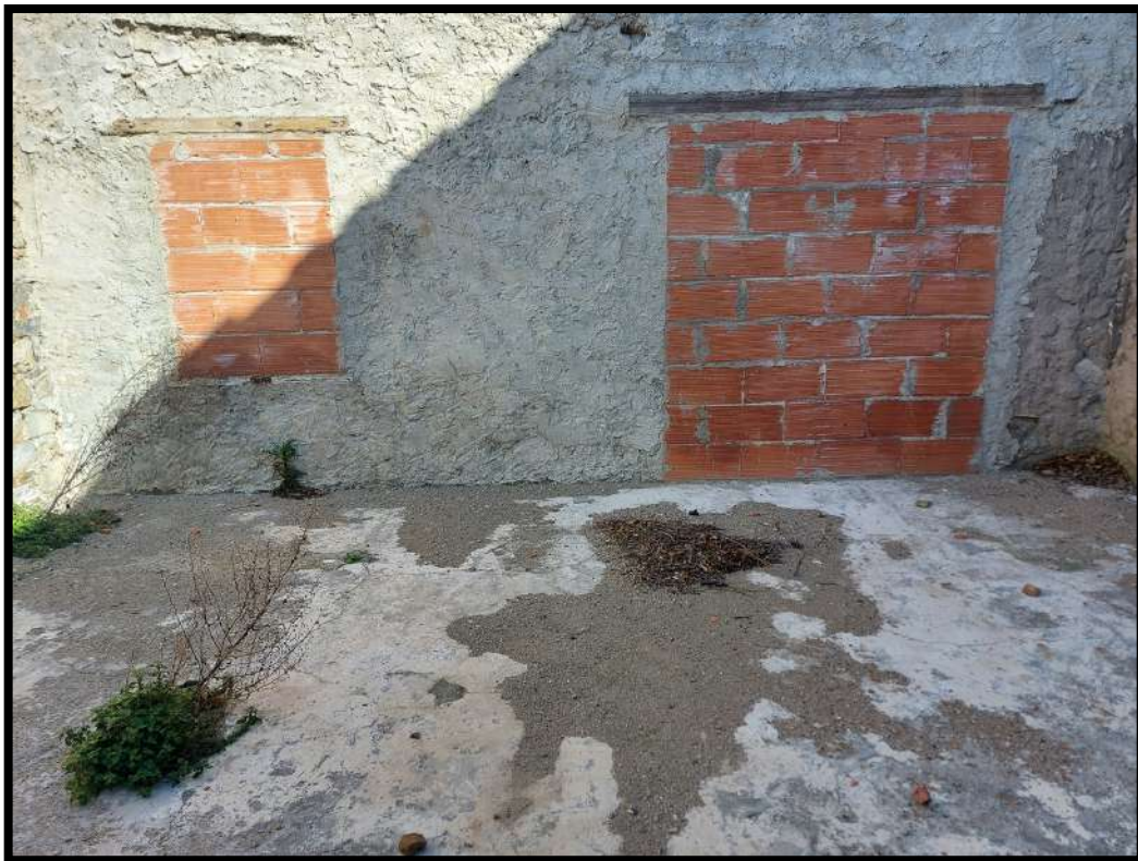
Foto n.9 – Magazzino (ex fienile). Vecchie aperture tamponate.
