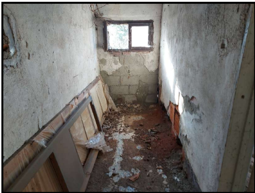
Foto n.4 – Disimpegno al piano primo.
