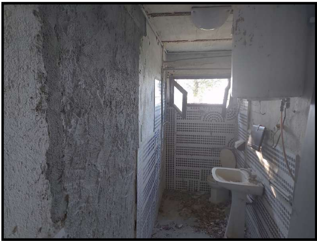
Foto n.2 – Bagno al piano terra. (Allaccio idrico con pozzo).
