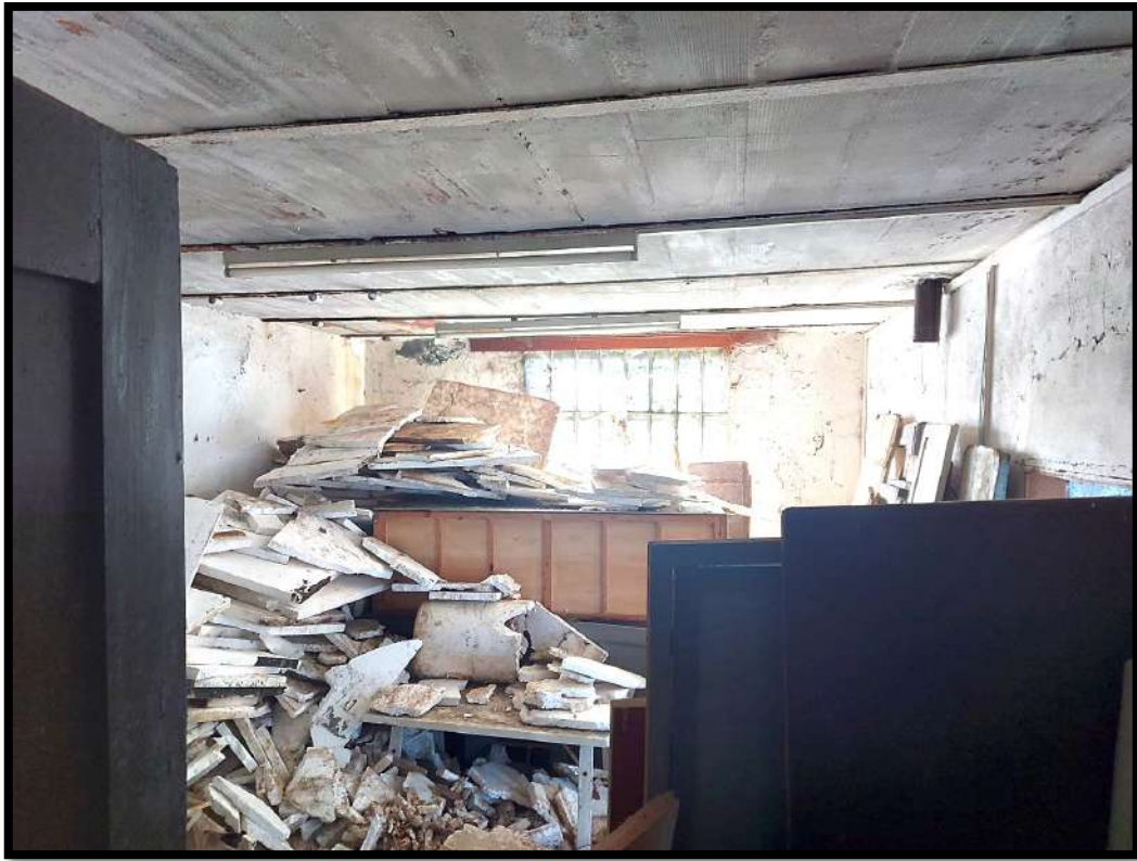
Foto n.7 –Magazzino adiacente alla Cucina.
