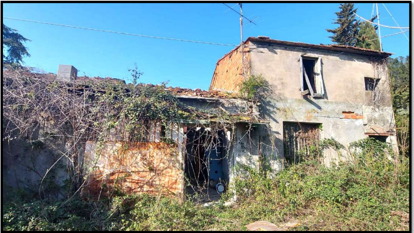
Foto n.1 – Prospetto Sud. Vista interna al lotto di pertinenza.
