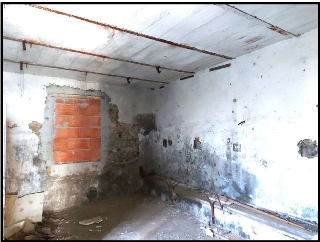
Foto n.16 – Secondo Magazzino (ex stalla).
