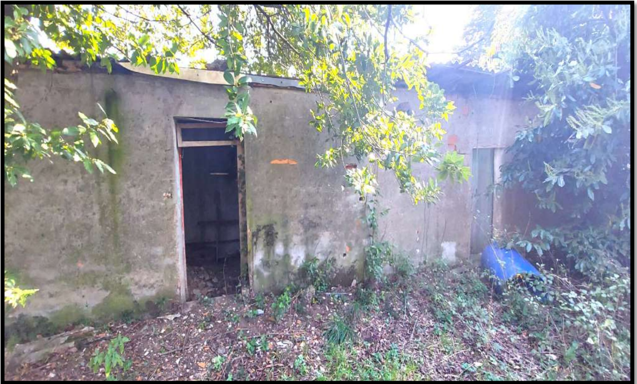
Foto n.7 – Prospetto frontale dell’annesso pertinenziale da demolire e ricostruire nel lotto.
