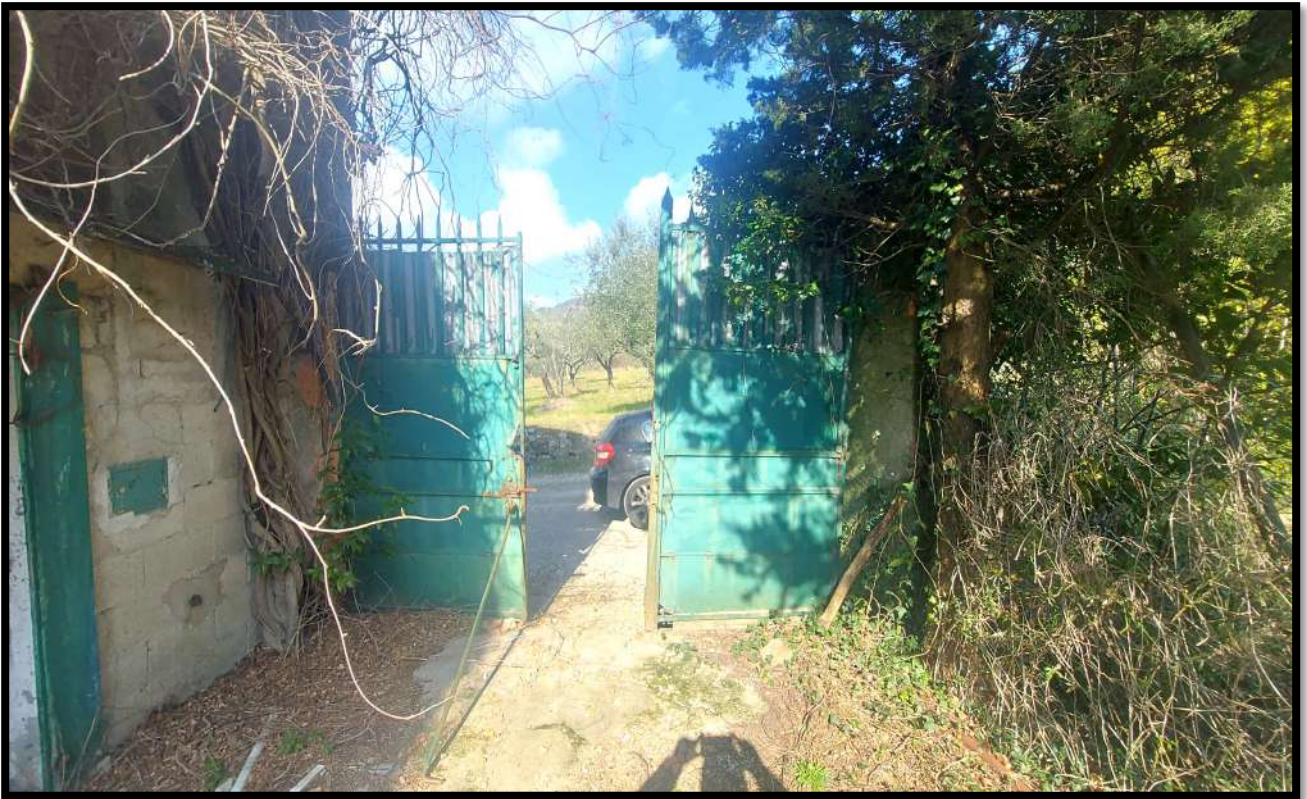
Foto n.5 – Ingresso carrabile adiacente edificio su via di Cerreto e Solano.
