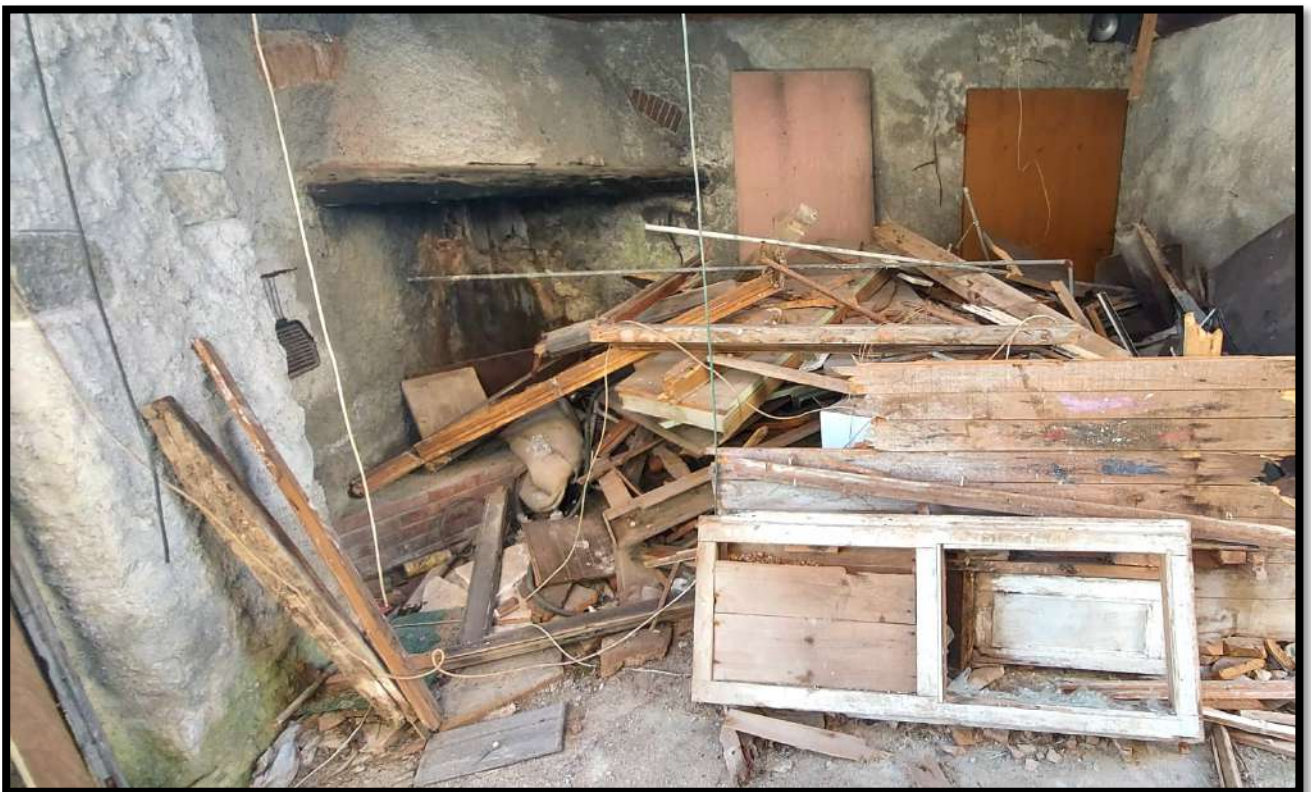
Foto n.8 – Magazzino (ex fienile).
