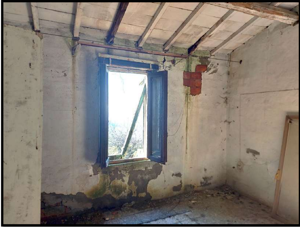
Foto n.5 – Prima Camera al piano primo.
