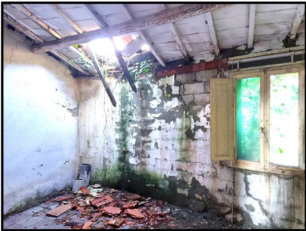
Foto n.6 – Seconda Camera al piano primo.
