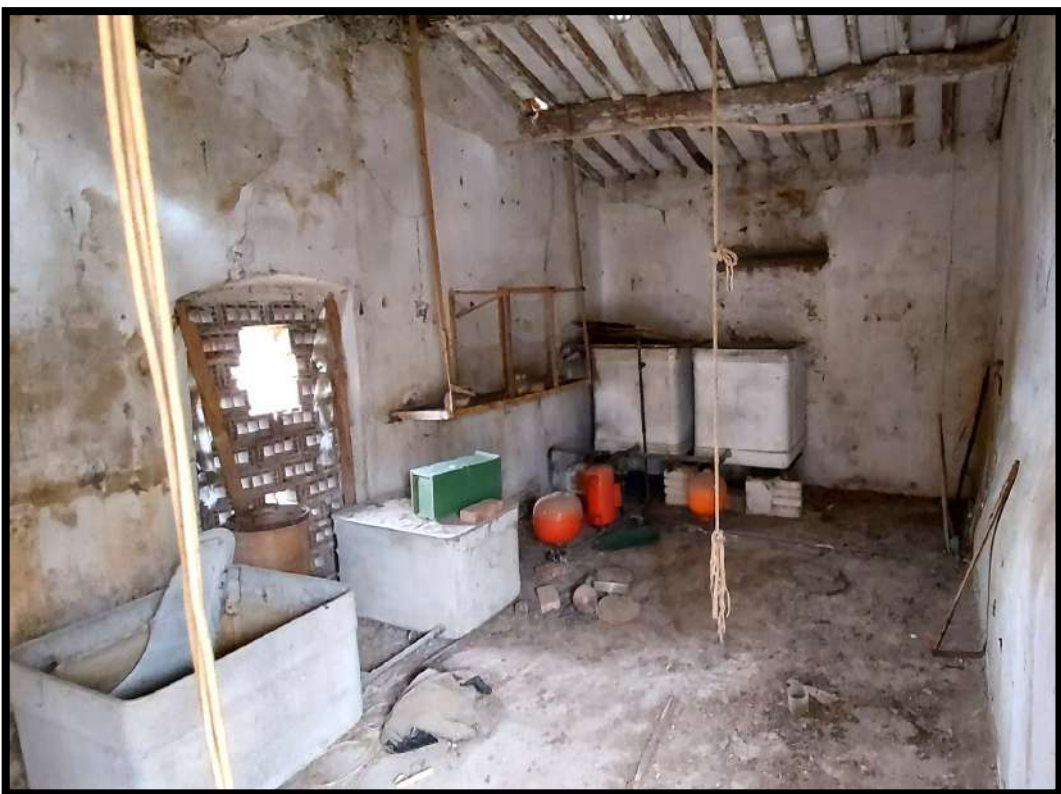
Foto n.12 – Vano al piano primo (ex fienile).
