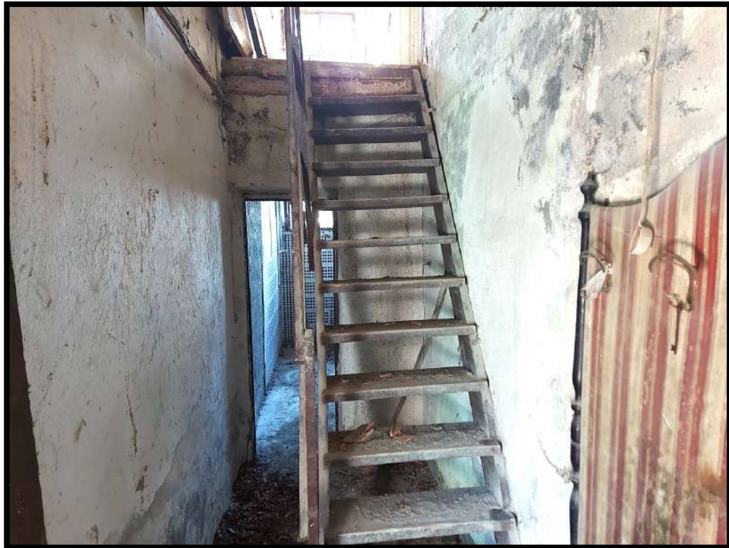
Foto n.3 – Scala in legno per accesso al piano primo.
