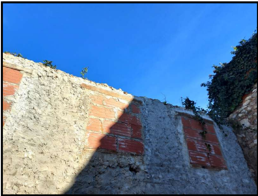
Foto n.14 – Vista lato opposto della foto n.13.
