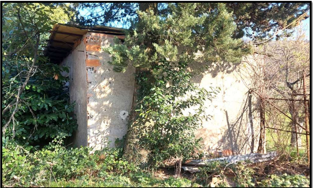
Foto n.8 – Vista Laterale Annesso pertinenziale da demolire e ricostruire.
