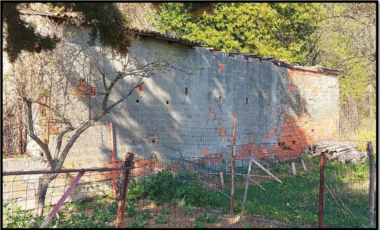
Foto n.9 – Vista tergale dell’annesso pertinenziale da demolire e ricostruire
