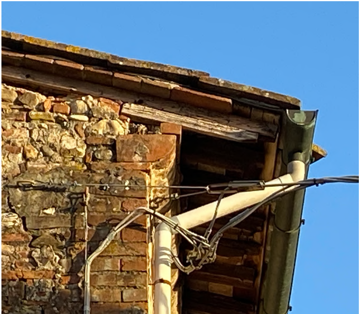
Particolare del laterizio sagomato sottotetto
