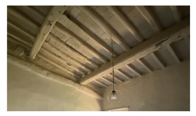
Forse sarà necessario sostituire qualche trave o travetto. Le sostituzioni di travi in legno dovranno essere eseguite con travi uso Fiume. Ovvero rastremate agli angoli per assomigliare il più possibile alle vecchie travi esistenti.
