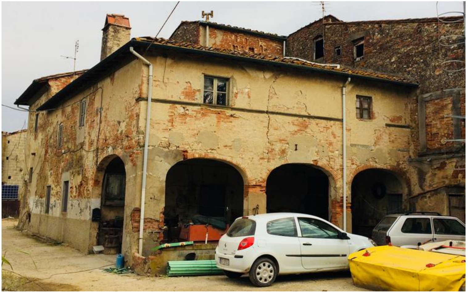
Porzione della parete sud.
