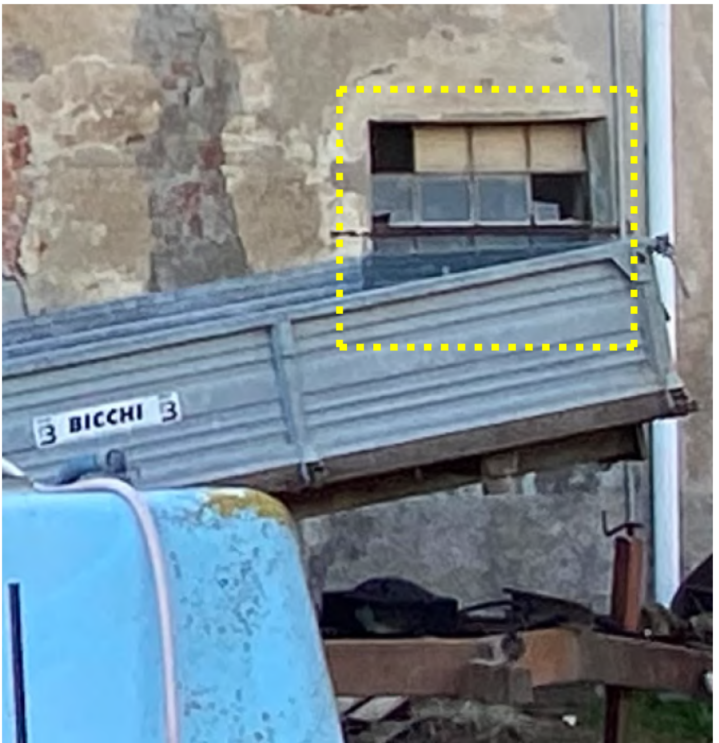
Apertura recente n° 9. Da mantenere.
