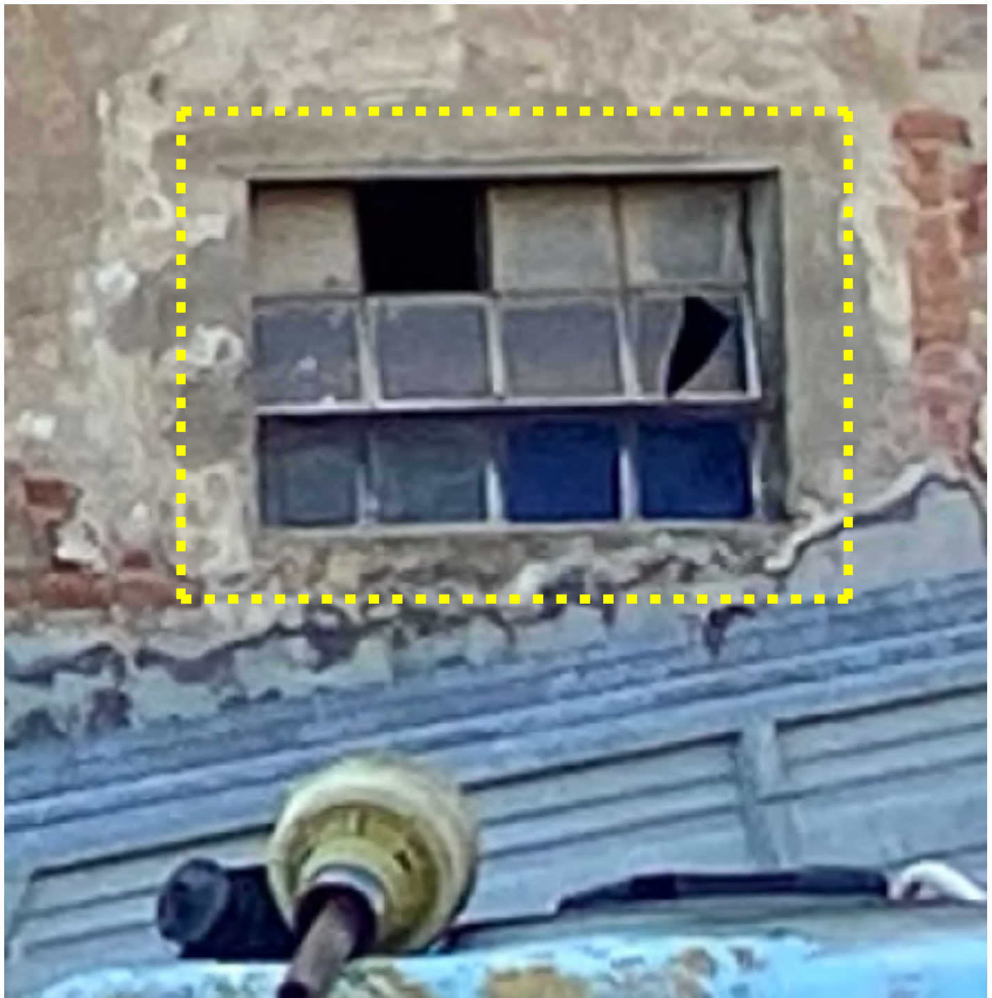
Apertura recente n° 10. Da mantenere.
