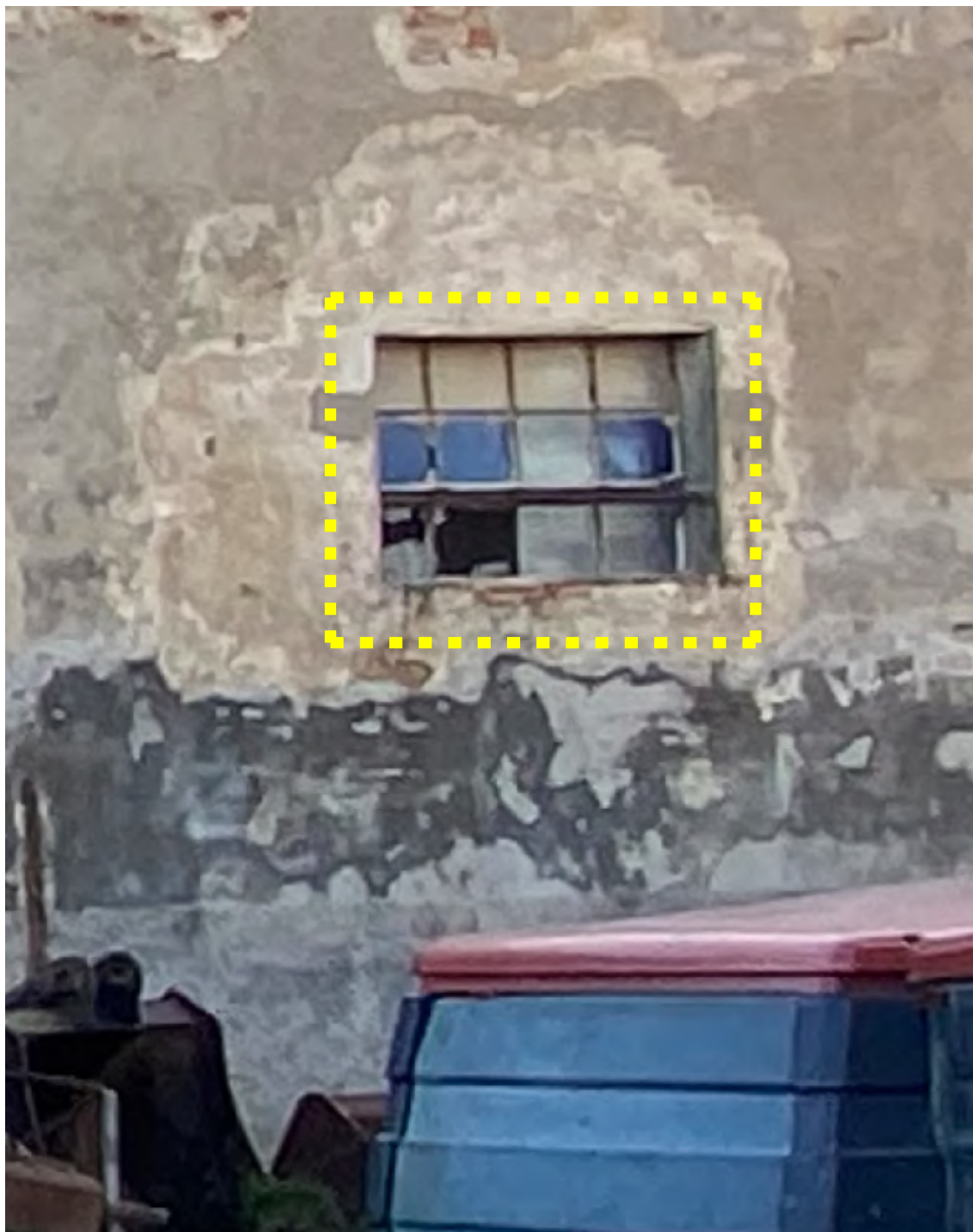
Apertura recente n° 8. Da mantenere.
