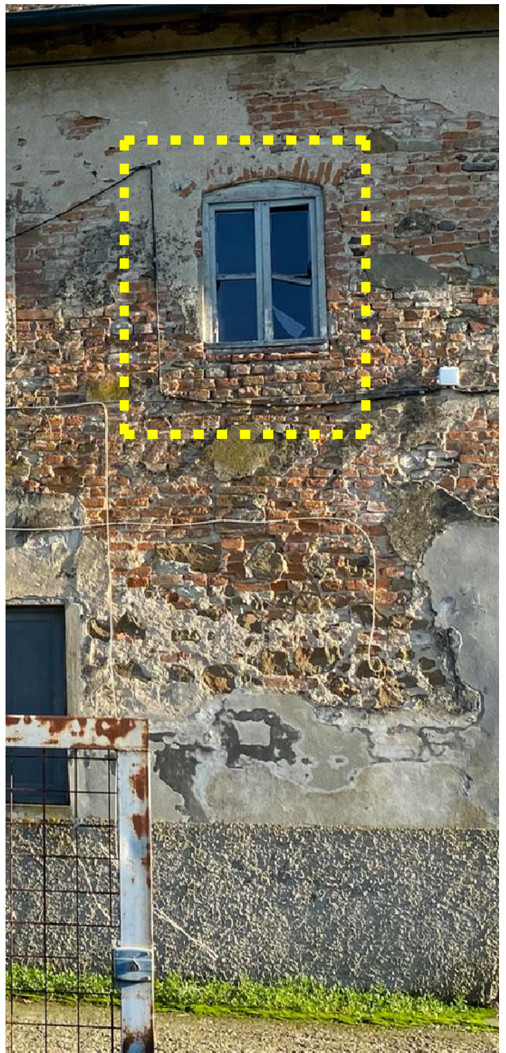
Finestra originaria n° 6. Da mantenere.
