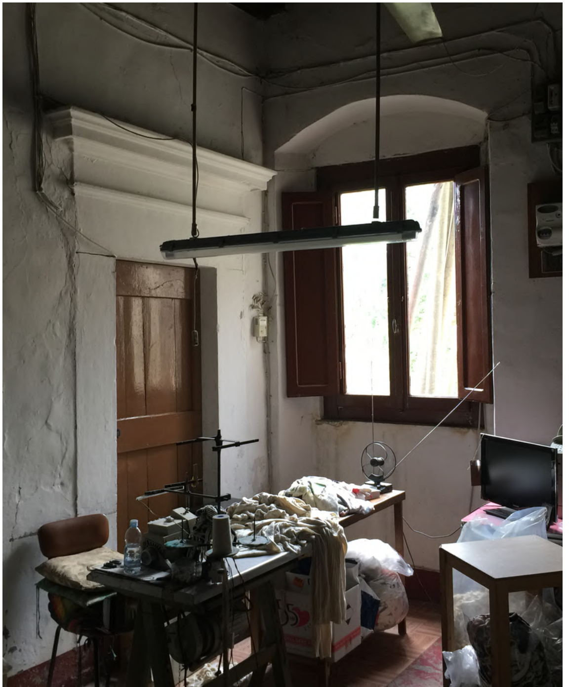
Interno della finestra con cornice lapidea da recuperare
