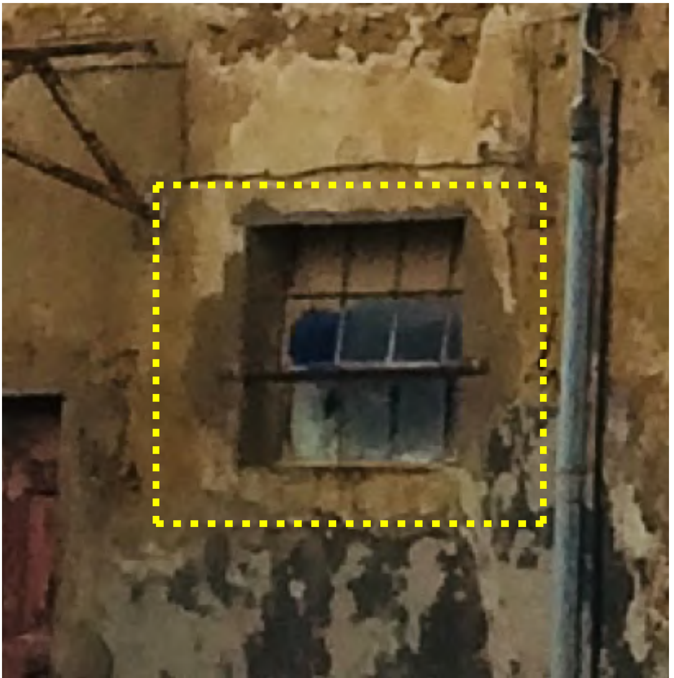
Apertura recente n° 11. Da mantenere.
