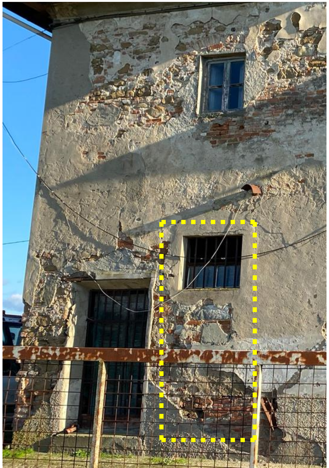
Finestra recente n° 3 con sottostante porta originaria )
