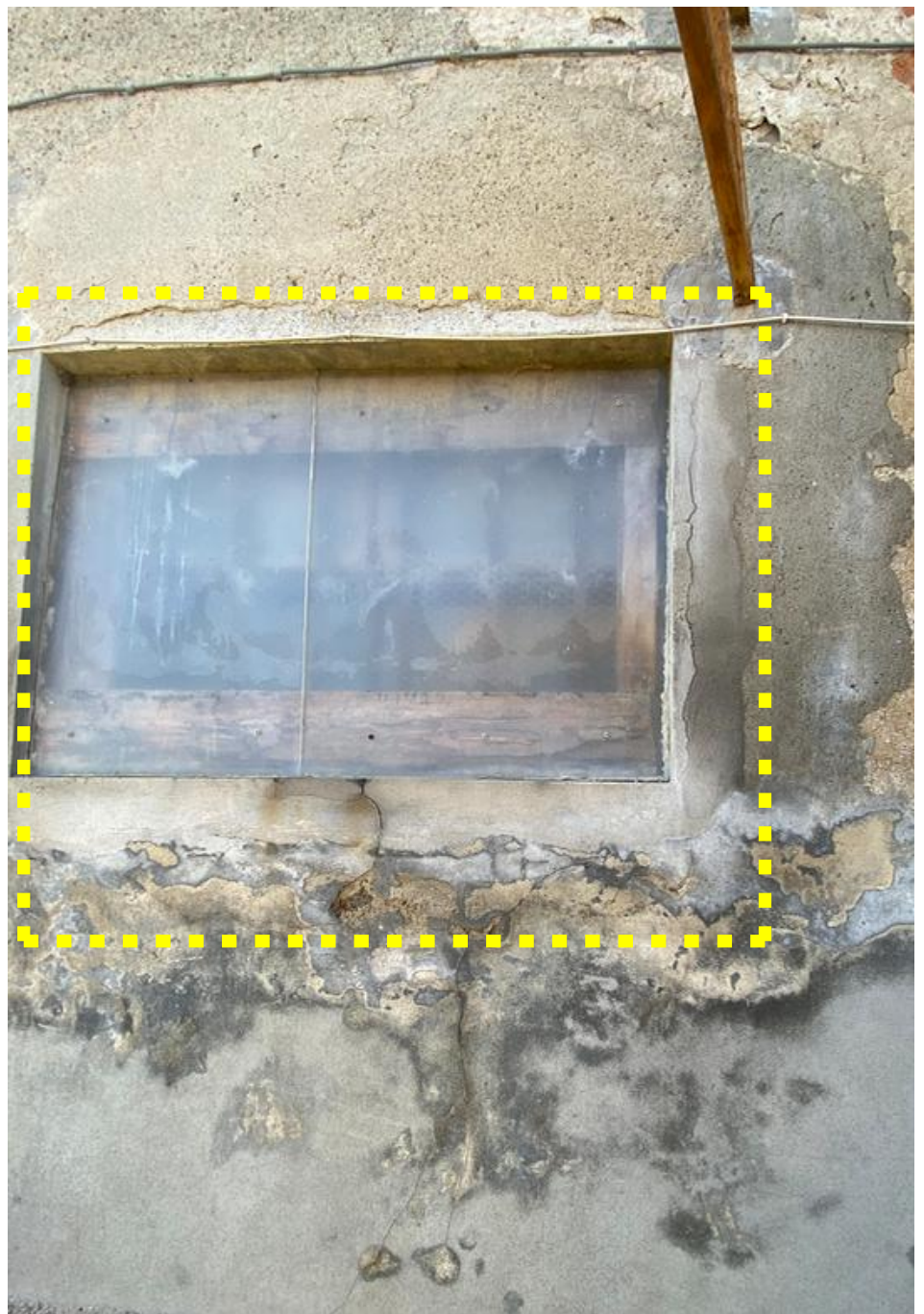
Apertura recente n° 13 Da mantenere.
