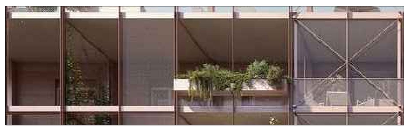
Particolare parapetti a fioriera e pannelli a tutta altezza in lamiera striata
