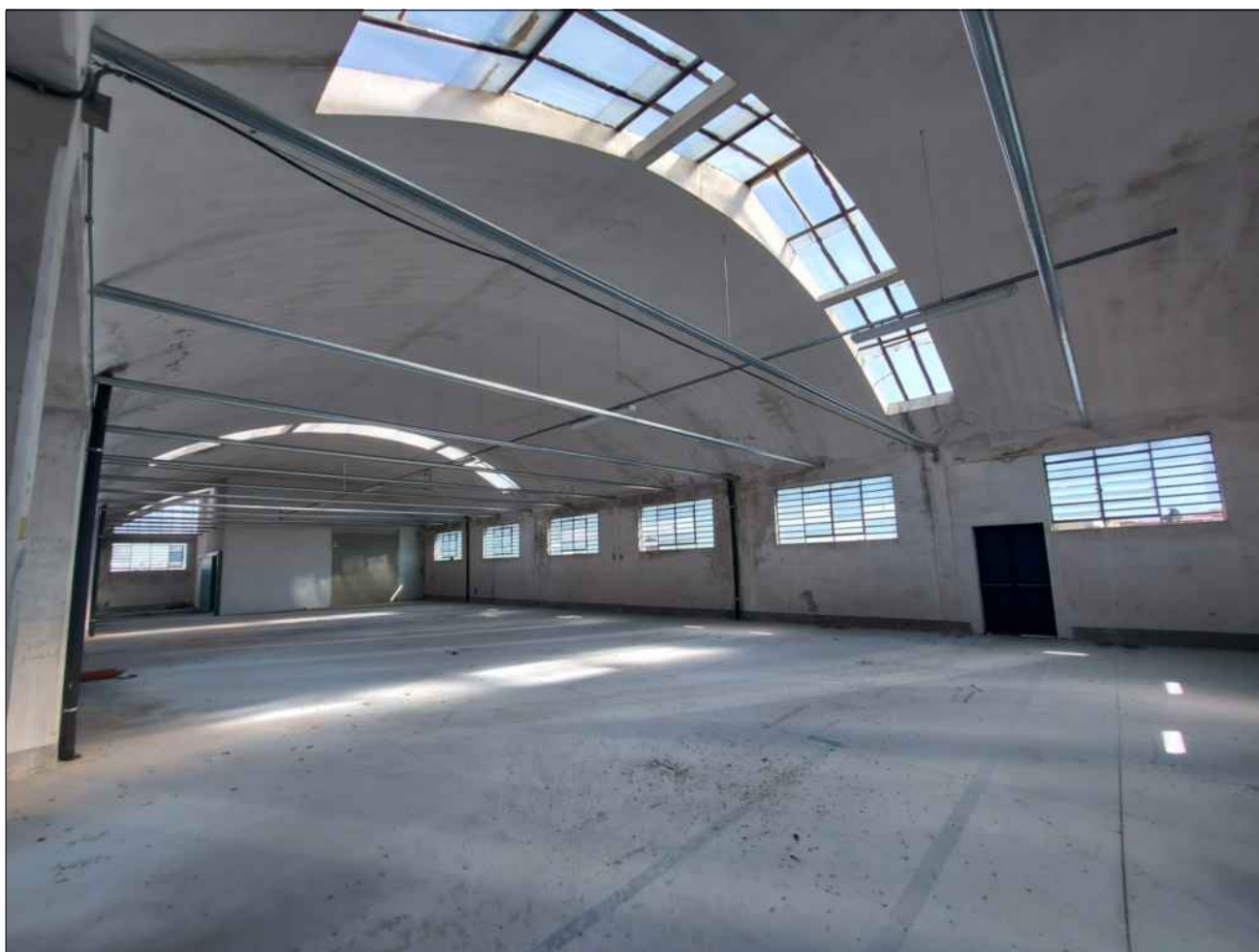
VISTA INTERNA DELL'EDIFICIO A TRE PIANI (PIANO SECONDO)
