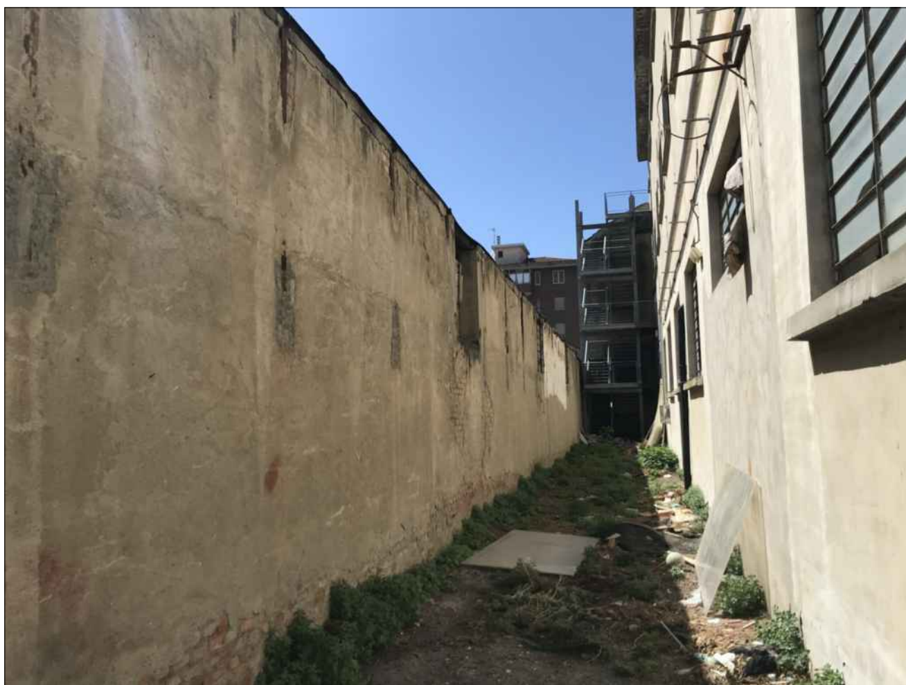
SCORCIO PROSPETTO LATERALE SINISTRO DELL'EDIFICIO A TRE PIANI DAL PIAZZALE PRIVATO
