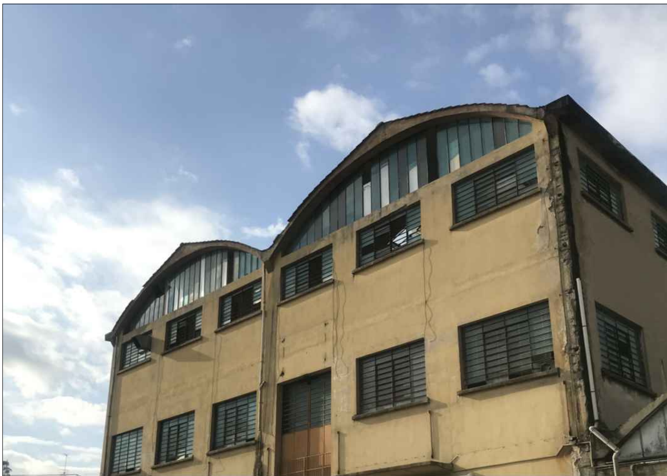
VISTA FRONTALE DELL'EDIFICIO A TRE PIANI DAL PIAZZALE PRIVATO
