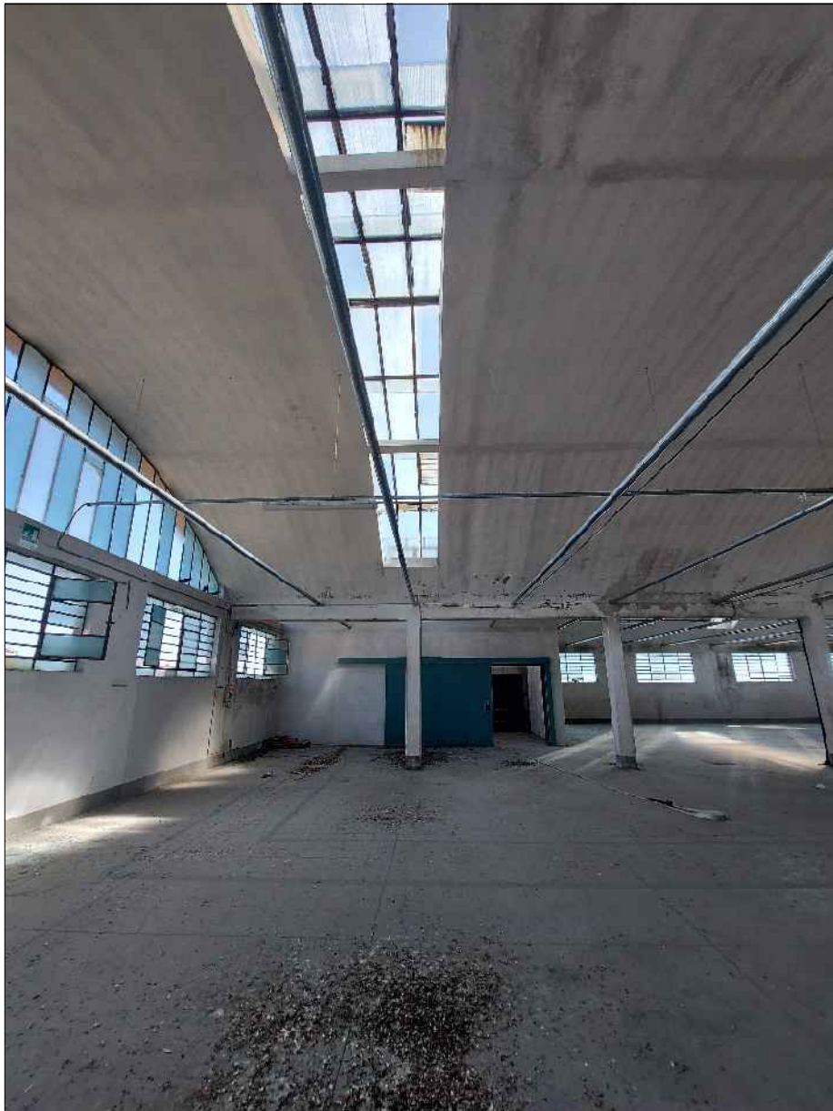
VISTA INTERNA DELL'EDIFICIO A TRE PIANI (PIANO SECONDO)
