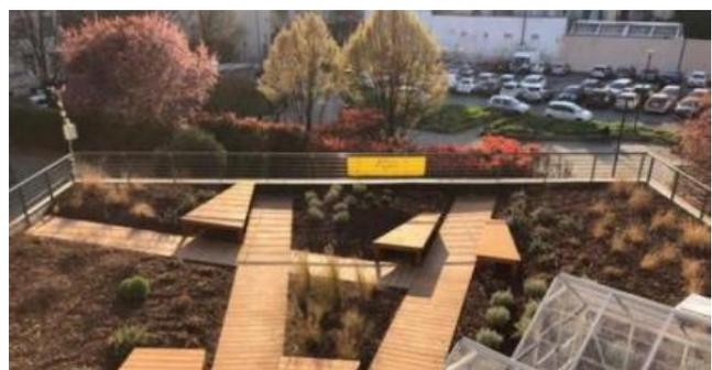
**Figura 77.** Esempio di intervento di disconnessione pluviali dei tetti, recupero meteoriche per irrigazione tetto verde intensivo e infiltrazione con rain garden: Ostello Open 011 di Torino (supporto tecnico al Comune di Torino di IRIDRA nell'ambito del progetto Interreg CWC).
