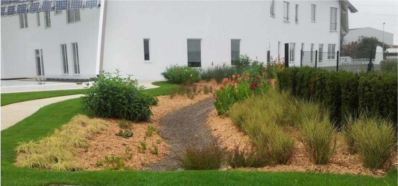
**Figura 64.** Esempio di come potrebbero risultare le ex gore non commistionate con fognatura mista, riconvertite come aree di bioritenzione asciutte e in grado di ricevere ed infiltrare le acque di pioggia delle superfici impermeabili limitrofe: il rain garden del centro di ricerche Kerakoll (progetto IRIDRA)
