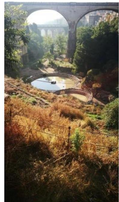
**Figura 70.** Esempio di parco riqualificato per mezzo di sistema di fitodepurazione inserito in area parco per il trattamento delle acque nere miste e restituzione di acque depurate al fosso attraversante l'area fruibile (planimetria di progetto e foto durante le fasi di realizzazione delle vasche): Vallata Santa Domenica, Ragusa (progetto IRIDRA)
