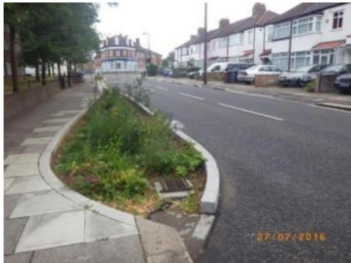
**Figura 49.** Esempio di retrofitting stradale con creazione di una area di bioritenzione con al suo interno il pozzetto stradale esistente, recuperato con funzione di troppo pieno. Alma Road Rain garden di Londra. Fonte: [www.susdrain.org](http://www.susdrain.org)
