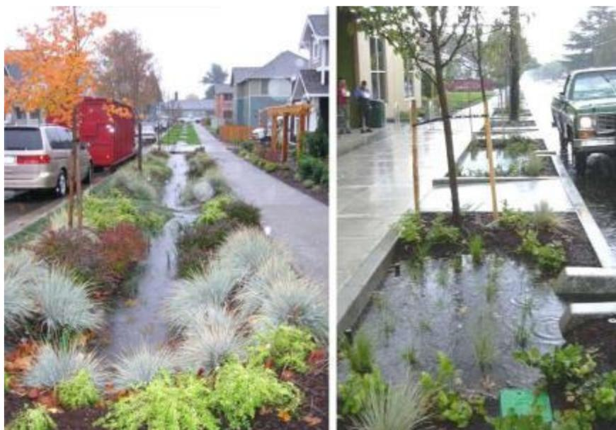
**Figura 18.** Esempi di interventi SuDS lungo carreggiate stradali durante eventi di pioggia
