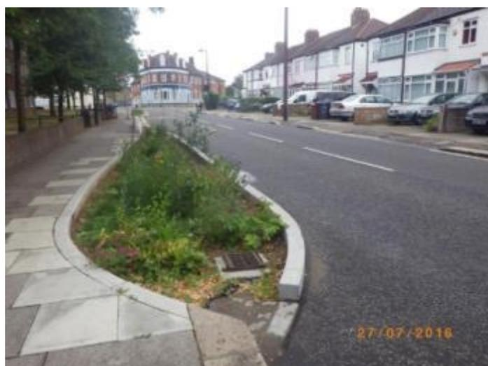
**Figura 28.** Esempio di retrofitting stradale con creazione di una area di bioritenzione con al suo interno il pozzetto stradale esistente, recuperato con funzione di troppo pieno. Alma Road Rain garden di Londra. Fonte: [www.susdrain.org](http://www.susdrain.org)
