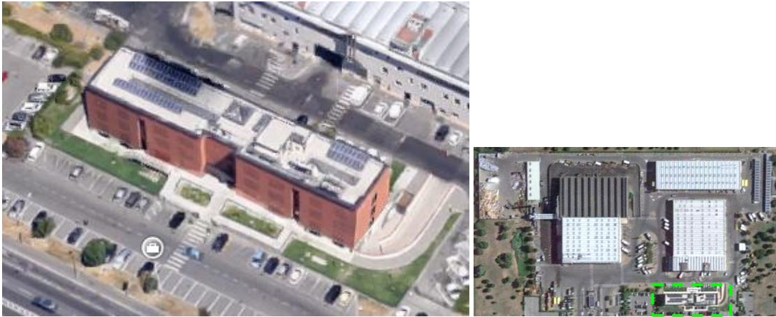
Figura 6 - Vista aerea del Lotto 4 (fonte: GoogleMaps).
