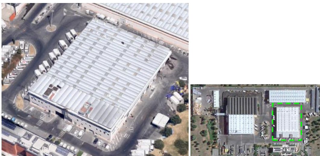
Figura 5 - Vista aerea del Lotto 3 (fonte: GoogleMaps).
