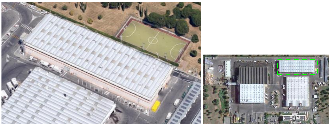
Figura 4 - Vista aerea del Lotto 2 (fonte: GoogleMaps).
