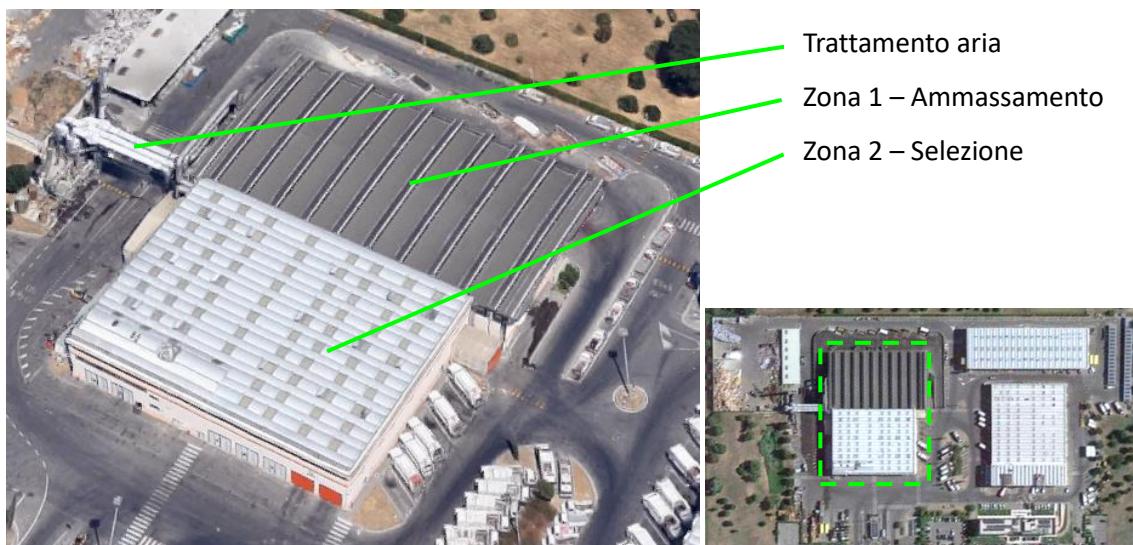
Figura 2 - Vista aerea del Lotto 1 – area interna (fonte: GoogleMaps).
