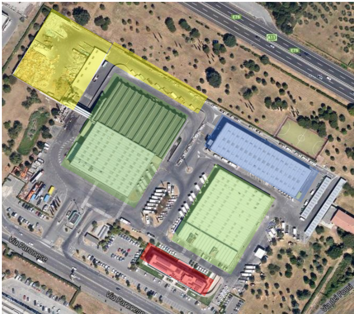
Figura 1 - Vista aerea del sito impiantistico di via Paronese (fonte: Google Maps) e individuazione delle aree funzionali: Lotto1 area interna (verde chiaro porzione anteriore+verde scuro porzione posteriore), Lotto 1 area esterna (giallo), Lotto 2 (azzurro), Lotto 3 (verde chiaro l'intero edificio), Lotto 4 (rosso).
