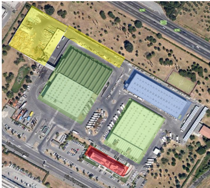
Figura 1 - Vista aerea del sito impiantistico di via Paronese (fonte: GoogleMaps) e individuazione delle aree funzionali: Lotto1 area interna (verde chiaro porzione anteriore+verde scuro porzione posteriore), Lotto 1 area esterna (giallo), Lotto 2 (azzurro), Lotto 3 (solo verde chiaro), Lotto 4 (rosso).
