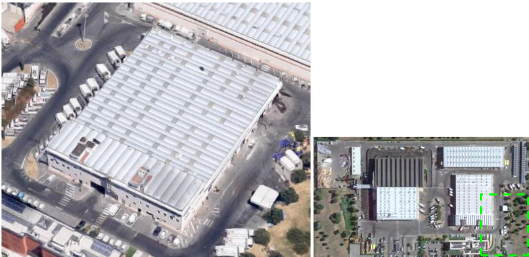
Figura 5 - Vista aerea del Lotto 3 (fonte: GoogleMaps).
