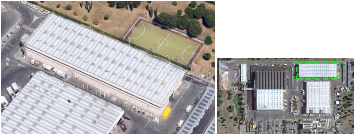
Figura 4 - Vista aerea del Lotto 2 (fonte: GoogleMaps).
