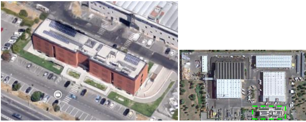
Figura 6 - Vista aerea del Lotto 4 (fonte: GoogleMaps).
